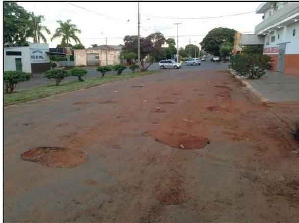
**Figura 18 –Deterioração Avançada com Painéis Profundas**
