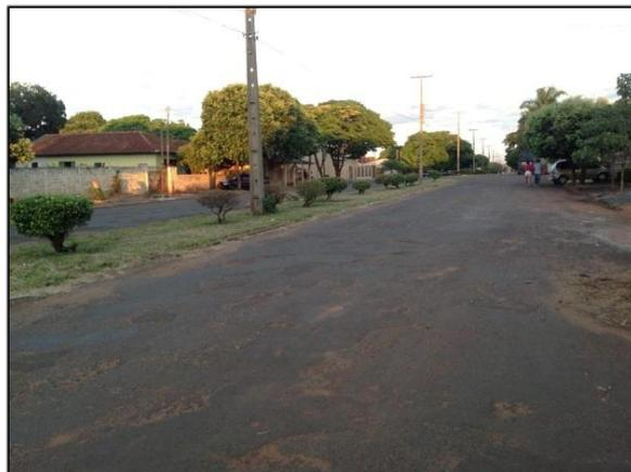
**Figura 17 – Frequência Constante de Remendos**
