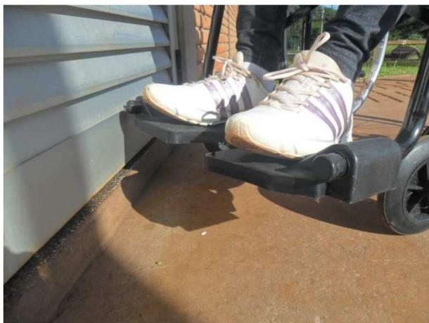
**Figura 16 - Degrau presente no acesso a parte inferior do bloco B.**
