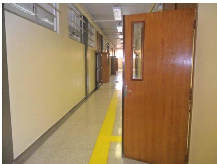
**Figura 20 - Circulação interna comprometida pela não abertura total das portas.**
