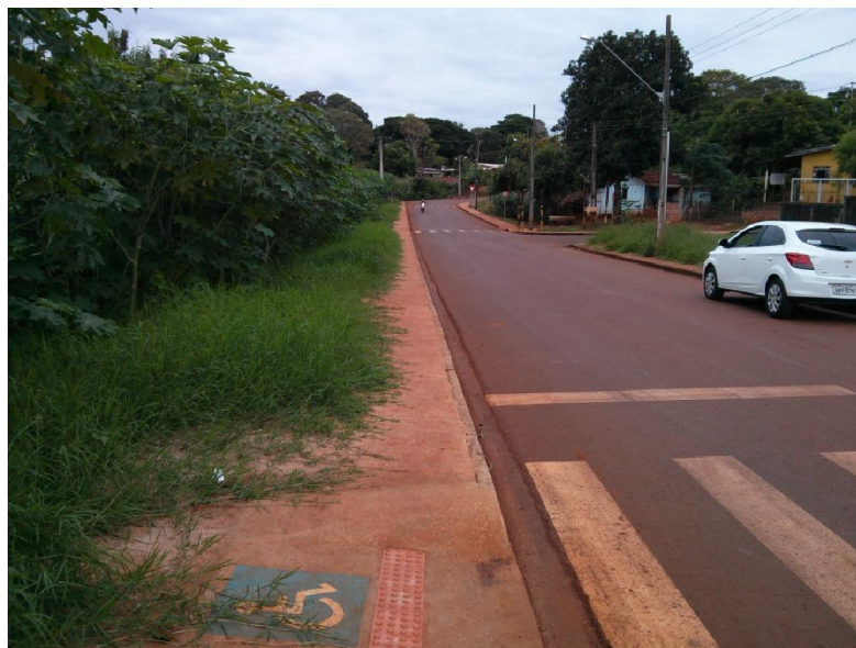
Fotografia 5 - Exemplo de obstáculos na faixa livre: vegetação cobrindo parte da calçada Fonte: Autoria própria.
