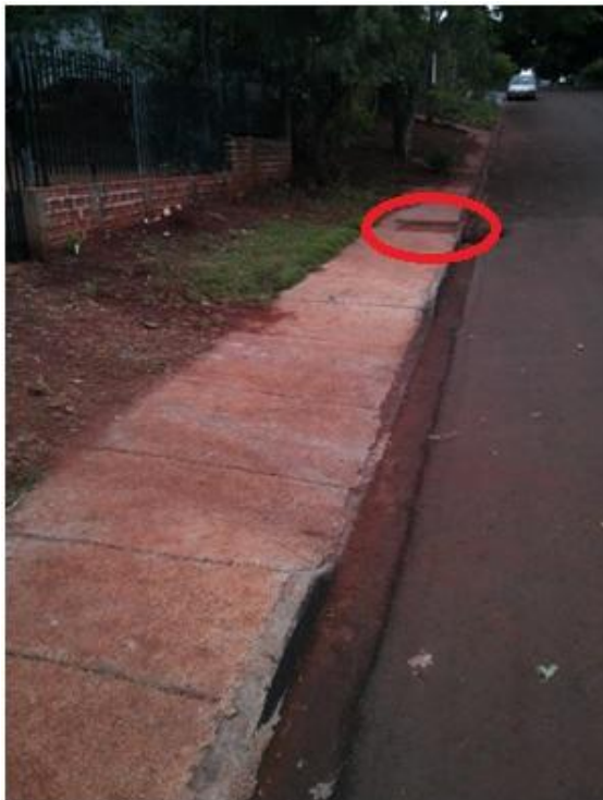
Fotografia 1 - Exemplo de obstáculos na faixa livre: tampa do bueiro desnivelada Fonte: Autoria própria.
