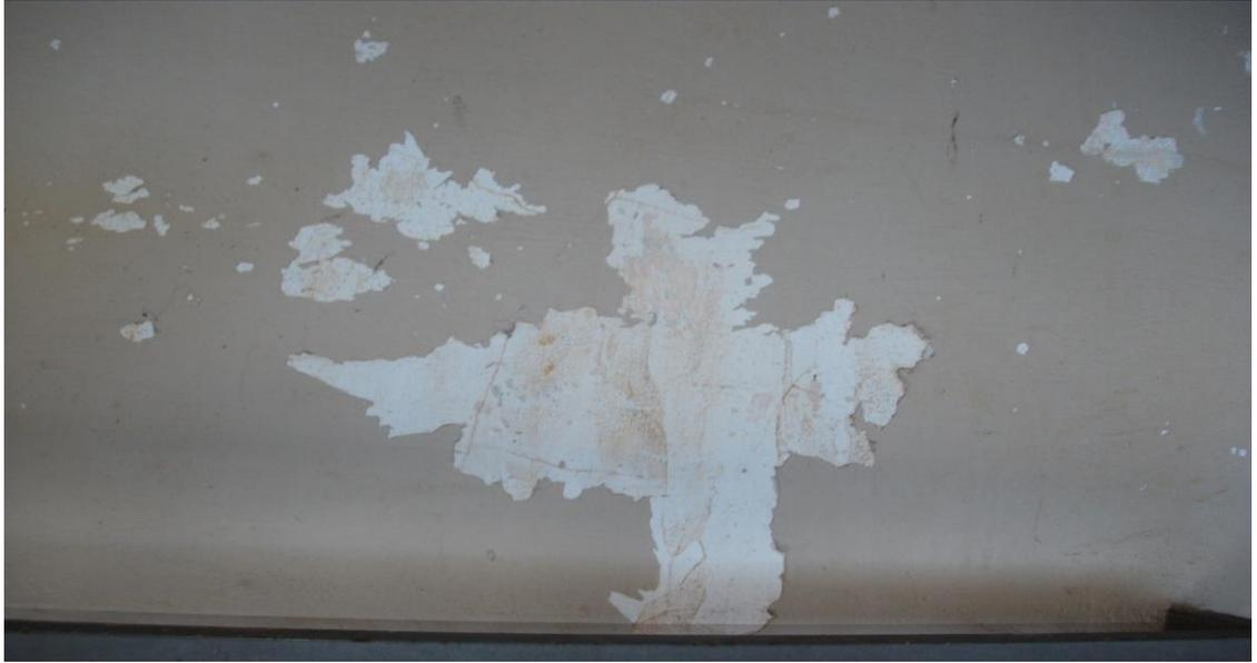
**Figura 11 – Descascamento de tinta em parede externa, coberta.**
