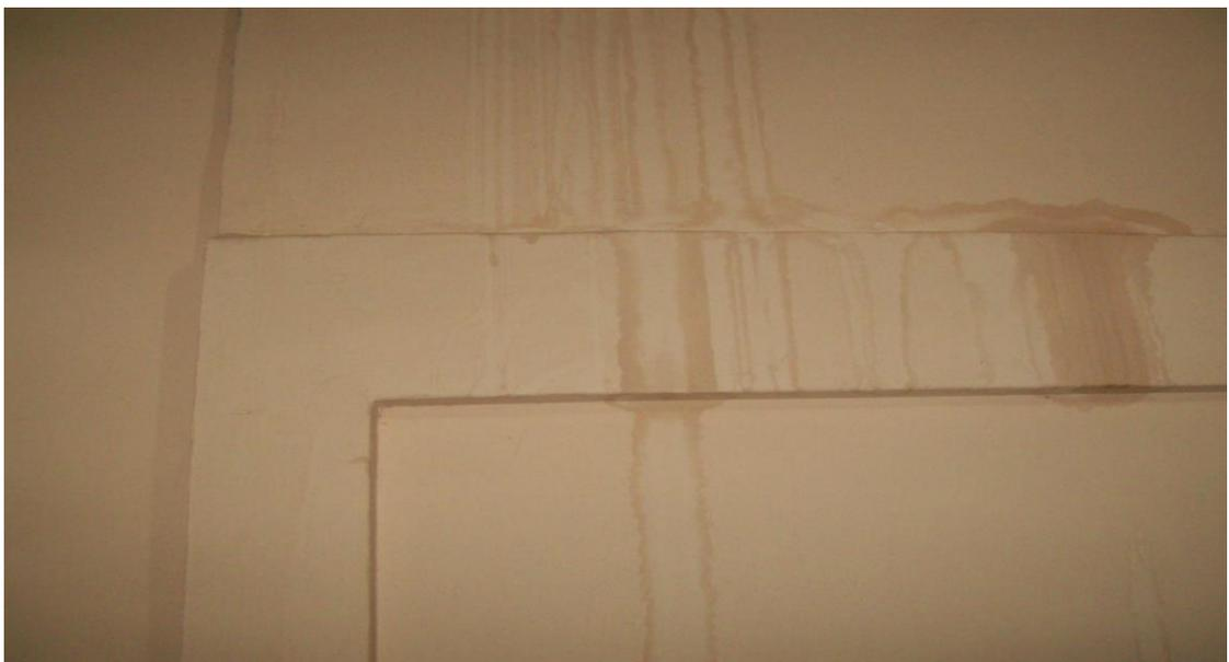
**Figura 17 – Presença de goteiras em laje de forro, prejudicando parede.**
