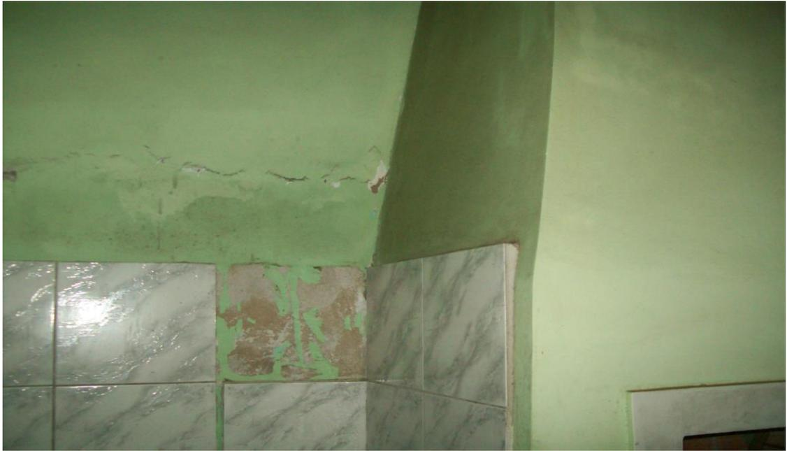
**Figura 13 – Destacamento de azulejo em parede externa coberta.**
