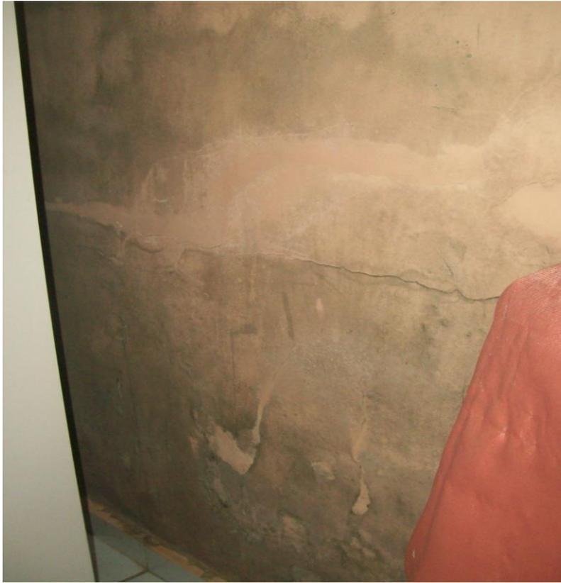
**Figura 7 – Presença de mofo em parede interna, sem exposição à umidade.**
