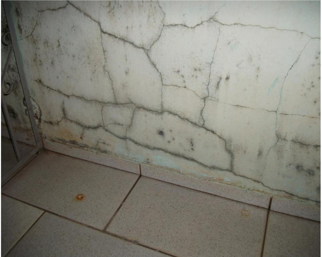
**Figura 4 – Fissuras, manchas e mofos em parede externa coberta.**
