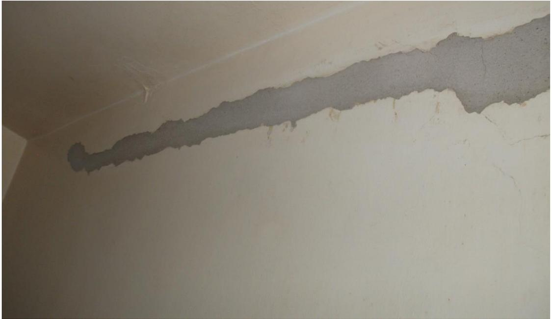
**Figura 6 – Recuperação de fissura em uma das residências visitadas.**
