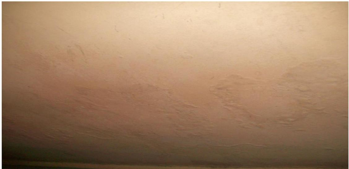
**Figura 10 – Bolhas em parede interna.**
