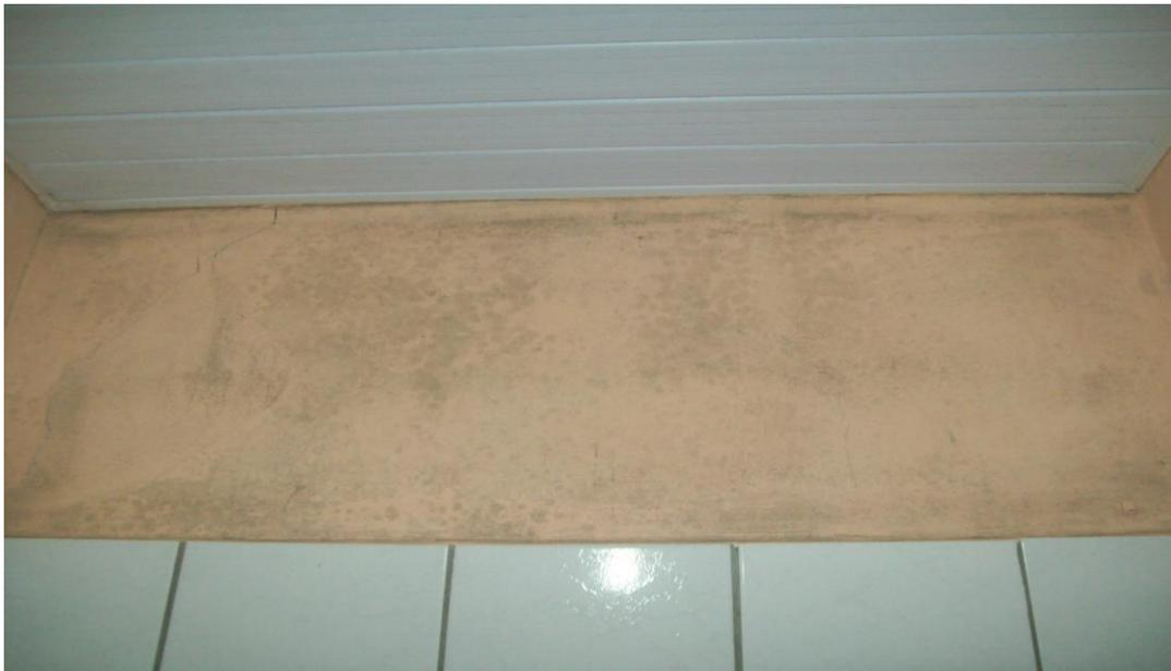
**Figura 8 – Presença de mofo em parede interna, com exposição à umidade.**
