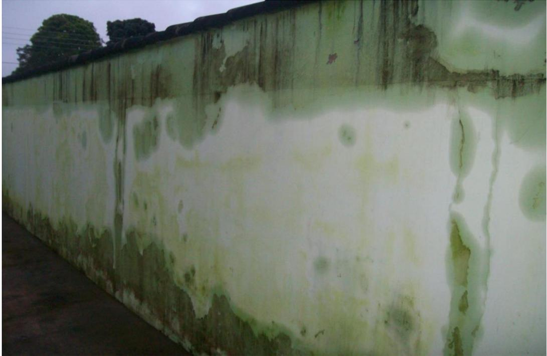
**Figura 9 – Presença de mofo em muro com exposição à umidade.**
