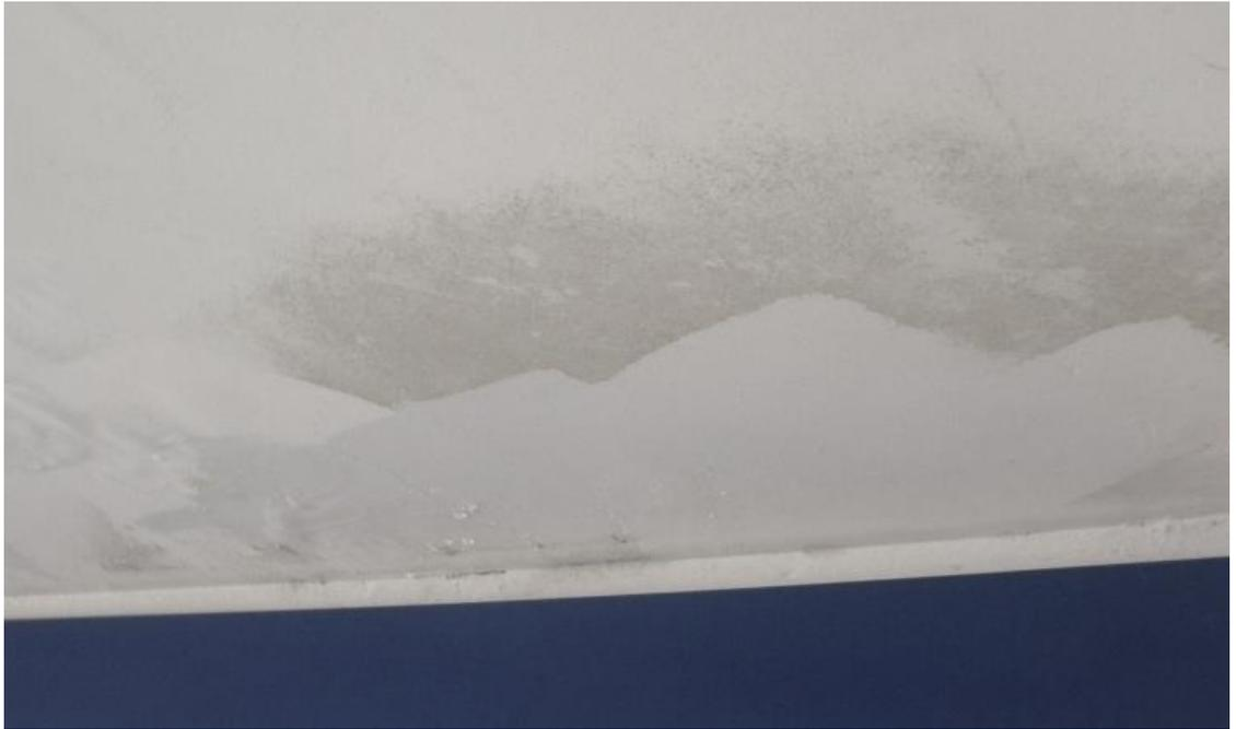
**Figura 18 – Presença de umidade em laje.**
