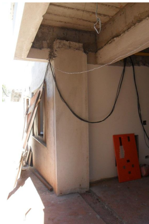
Figura 48 - Boneca na parede oposta à boneca hidráulica
