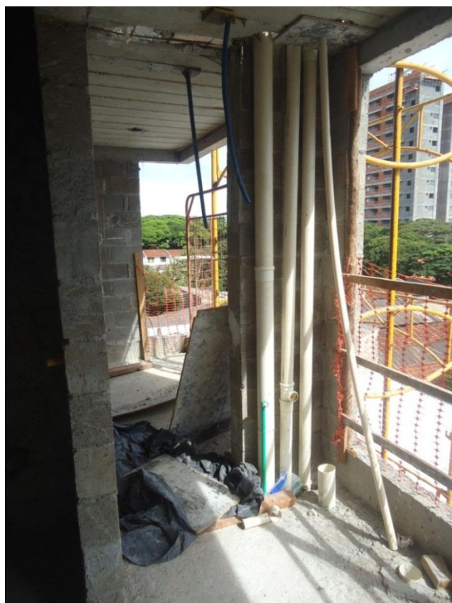
Figura 82 - Tubulações hidrossanitárias da sacada
