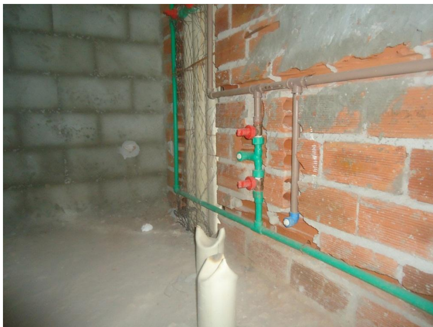
Figura 81 - Parede de vedação entre banheiros
