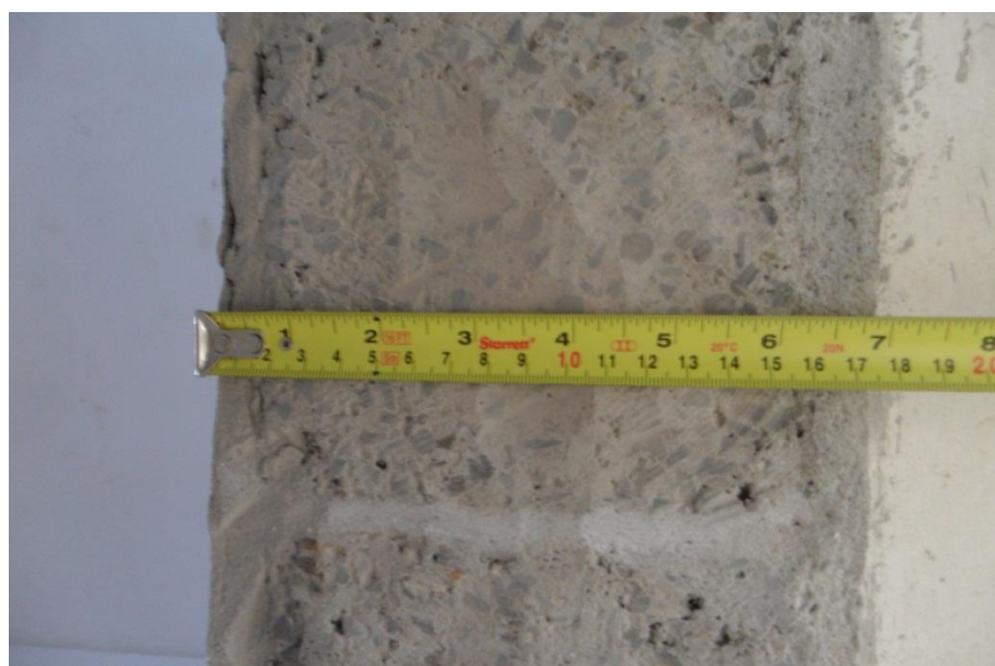
Figura 78 - Espessura da parede emboçada
