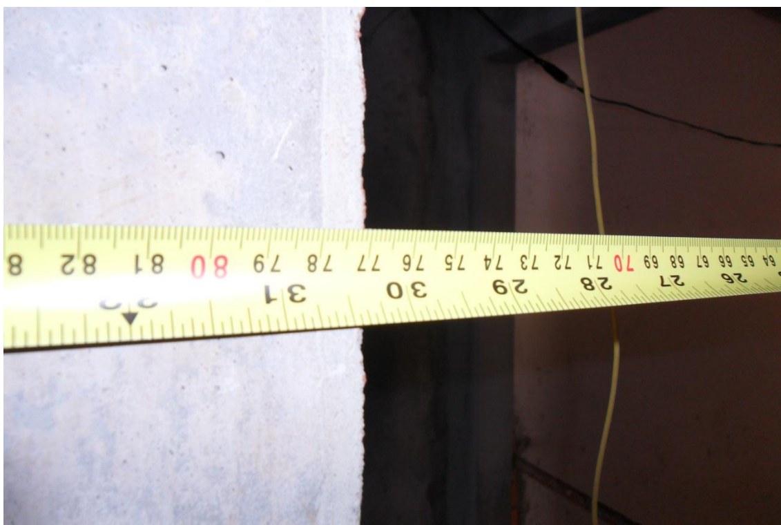
Figura 40 - Vão deixado para a porta do espaço fitness.
