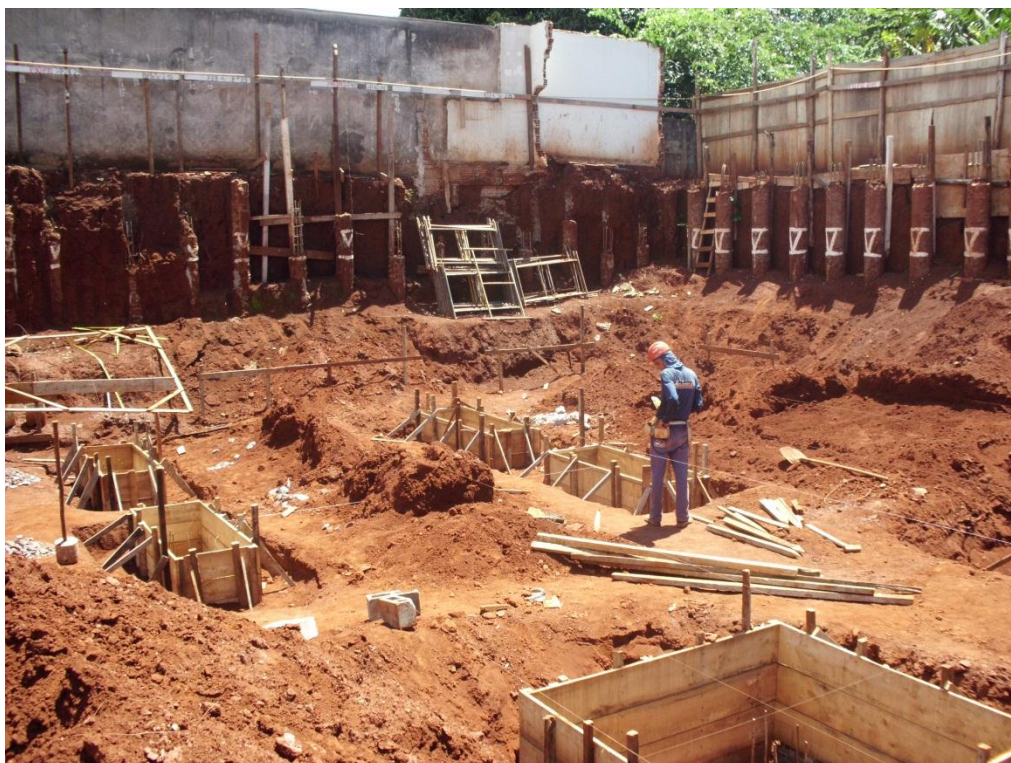
Figura 11 - Estacas da cortina de contenção do terreno que, por projeto, ficariam aparentes nos pavimentos subsolos Fonte: Arquivo fornecido pela construtora.
