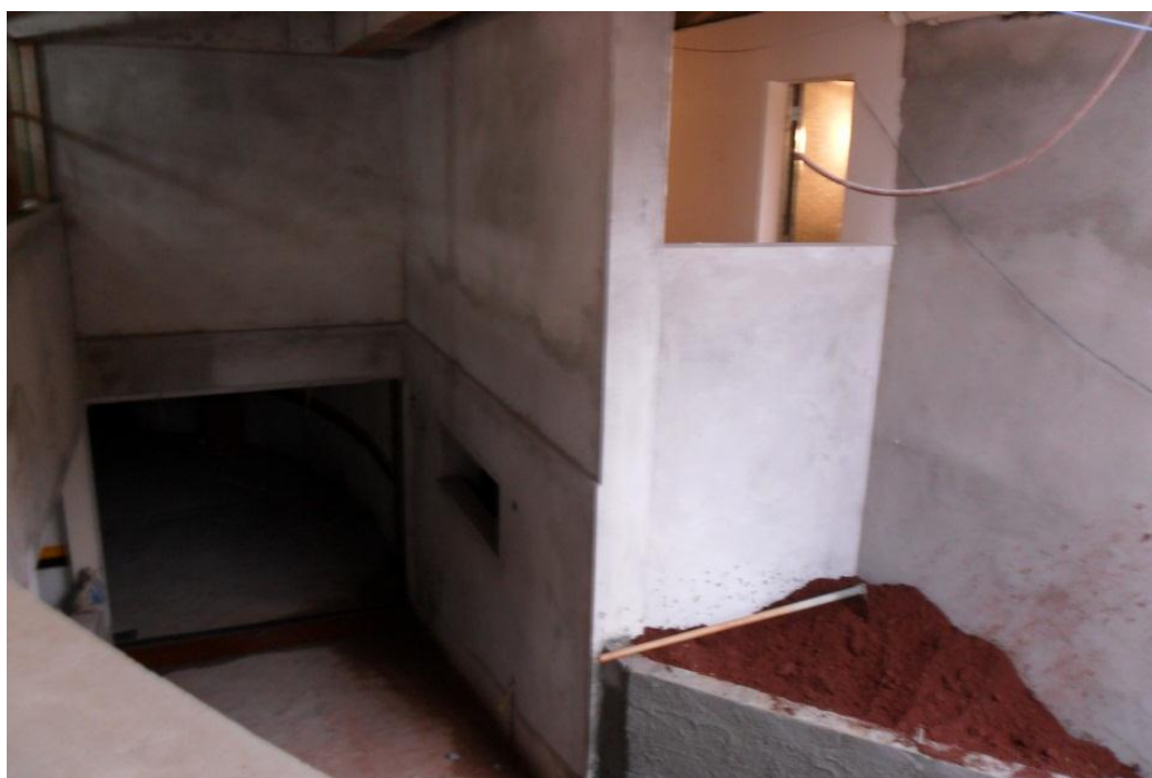
Figura 44 - Visão externa do corredor de acesso à escadaria do subsolo.
