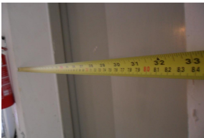
Figura 71 - Largura do vão do elevador executado
