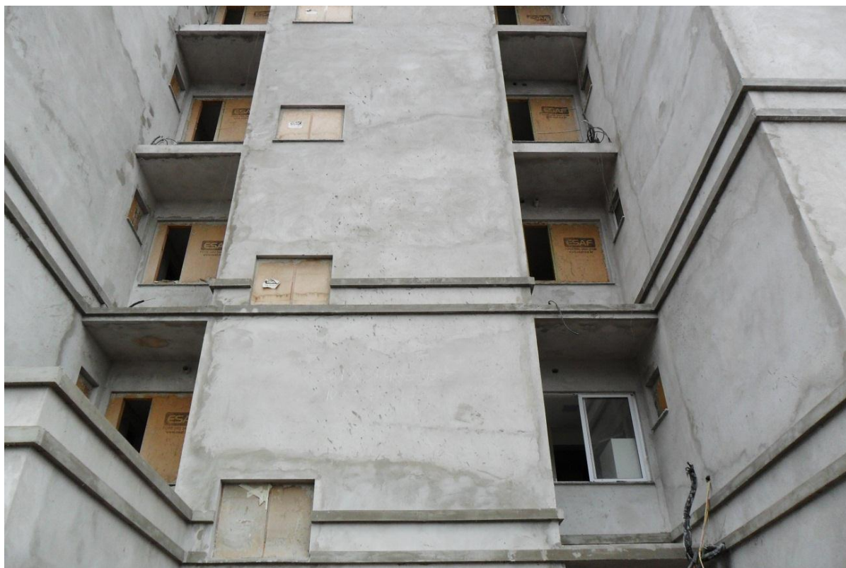
Figura 91 - Lajes executadas na lateral da área de serviço (lado direito do edifício)
