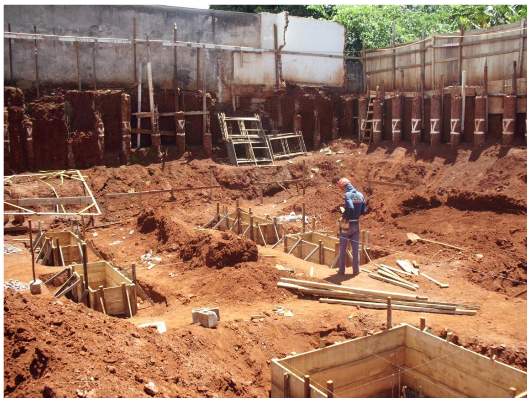
Figura 24 – Cortina de estacas da contenção periférica do terreno ao fundo (repetição da figura 11, utilizada nos resultados e discussões, p. 45) Fonte: Arquivo fornecido pela construtora.
