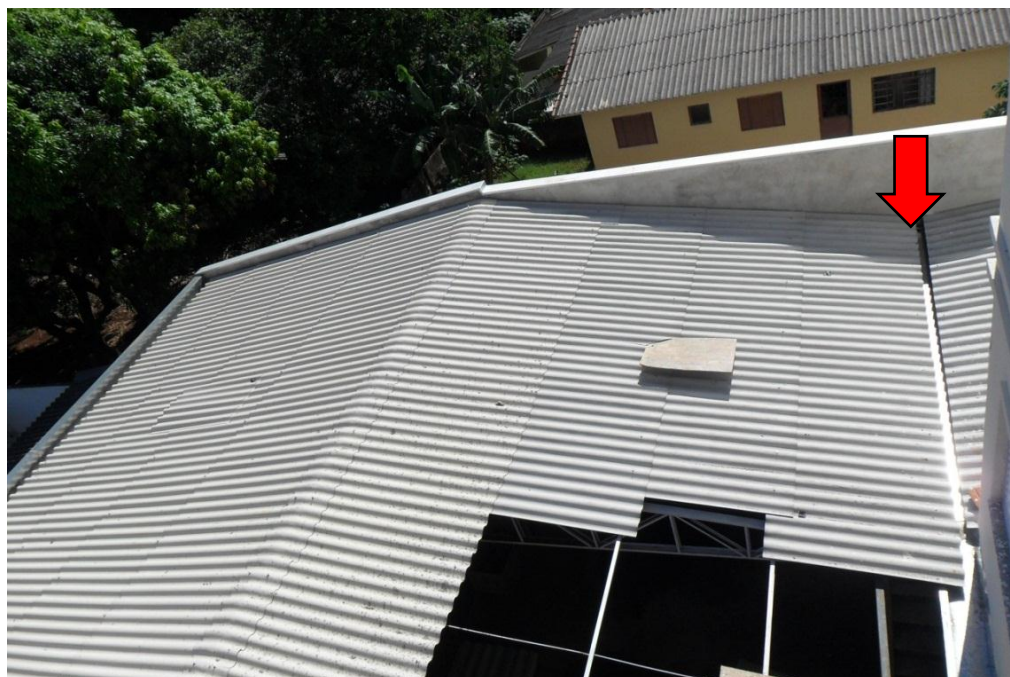
Figura 50 - Divisão de águas do telhado do estacionamento do pavimento térreo (seta indica final da segunda água alinhada às janelas dos quartos 1 e 2)
