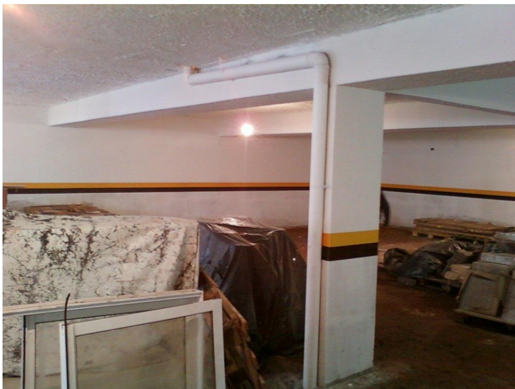
Figura 25 - Paredes dos subsolos lisas (sem estacas aparentes)
