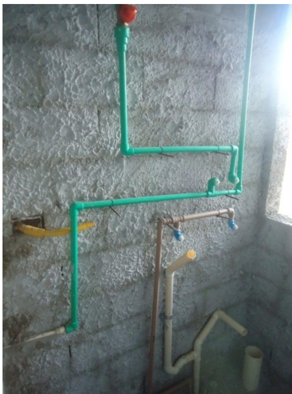
Figura 87 - Tubulações hidráulicas na parede atrás do tanque
