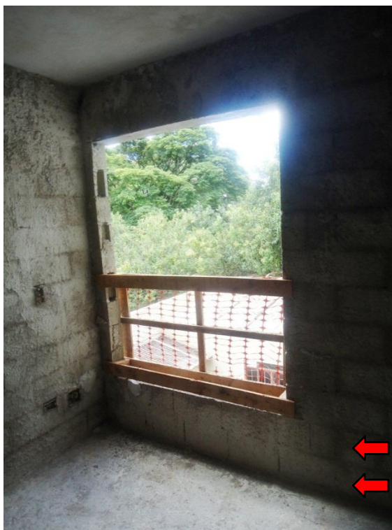
Figura 68 - Janela da suíte (setas indicam duas fiadas de blocos)
