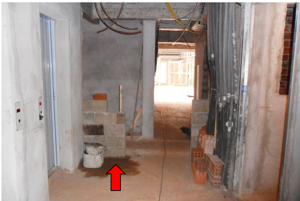
Figura 41 - Hall dos elevadores e acessos (Seta indica começo da construção da parede que foi retirada para evitar estrangulamento do corredor)
