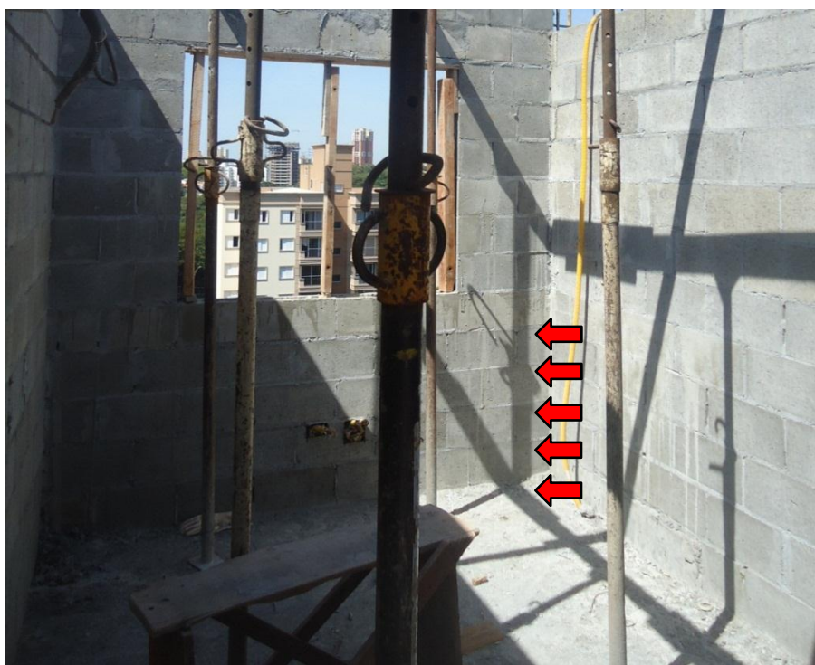
Figura 69 - Janela dos quartos 1 e 2 (setas indicam as cinco fiadas de blocos)
