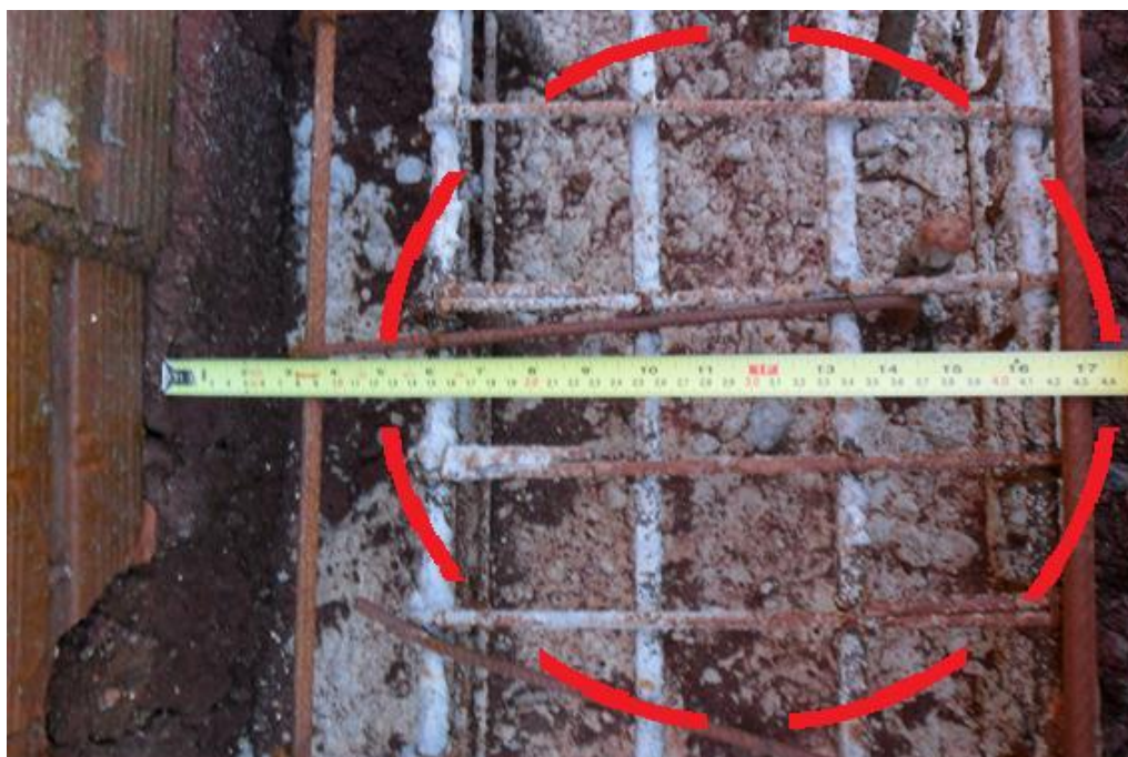
Figura 12 - Projeção de uma estaca da contenção periférica do terreno e sua distância em relação à divisa do terreno. Fonte: Adaptado de arquivo fornecido pela construtora.
