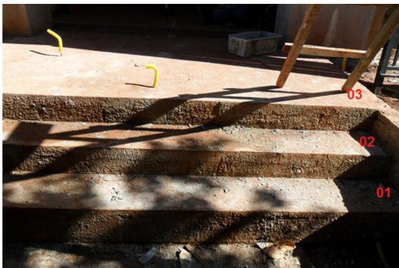
Figura 37 - Degraus da entrada do edifício
