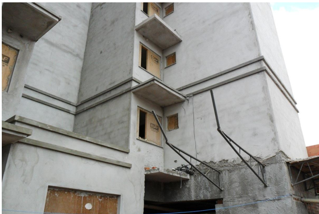
Figura 90 - Lajes executadas na lateral da área de serviço (lado esquerdo do edifício)
