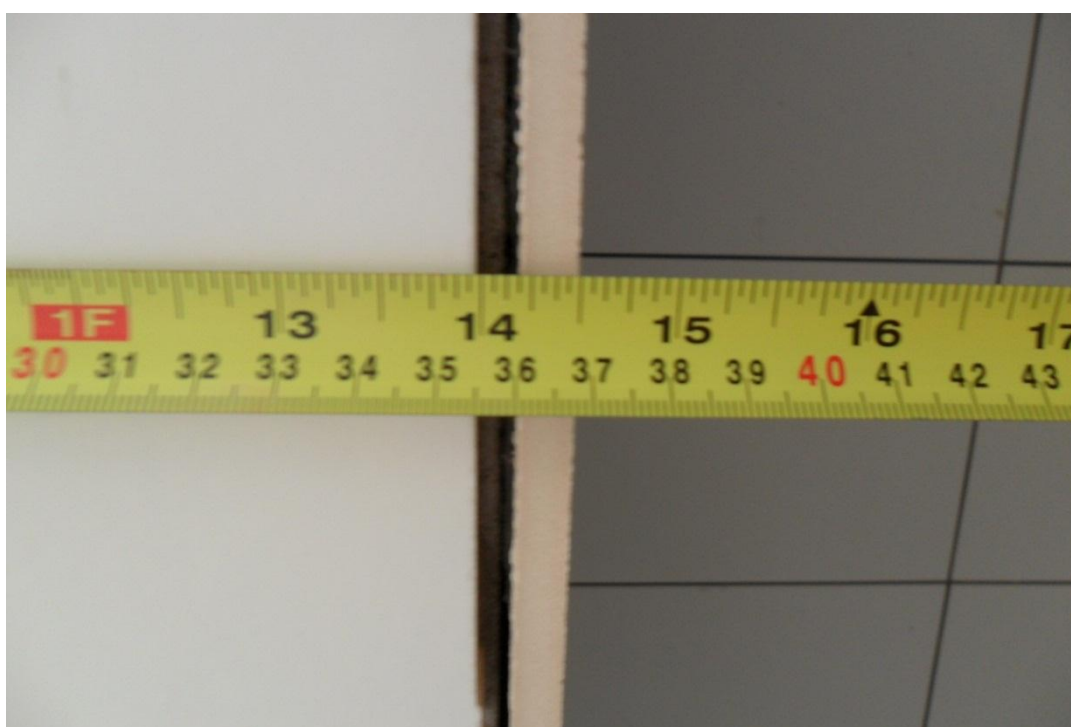
Figura 86 - Espessura da parede entre cozinha e área de serviço
