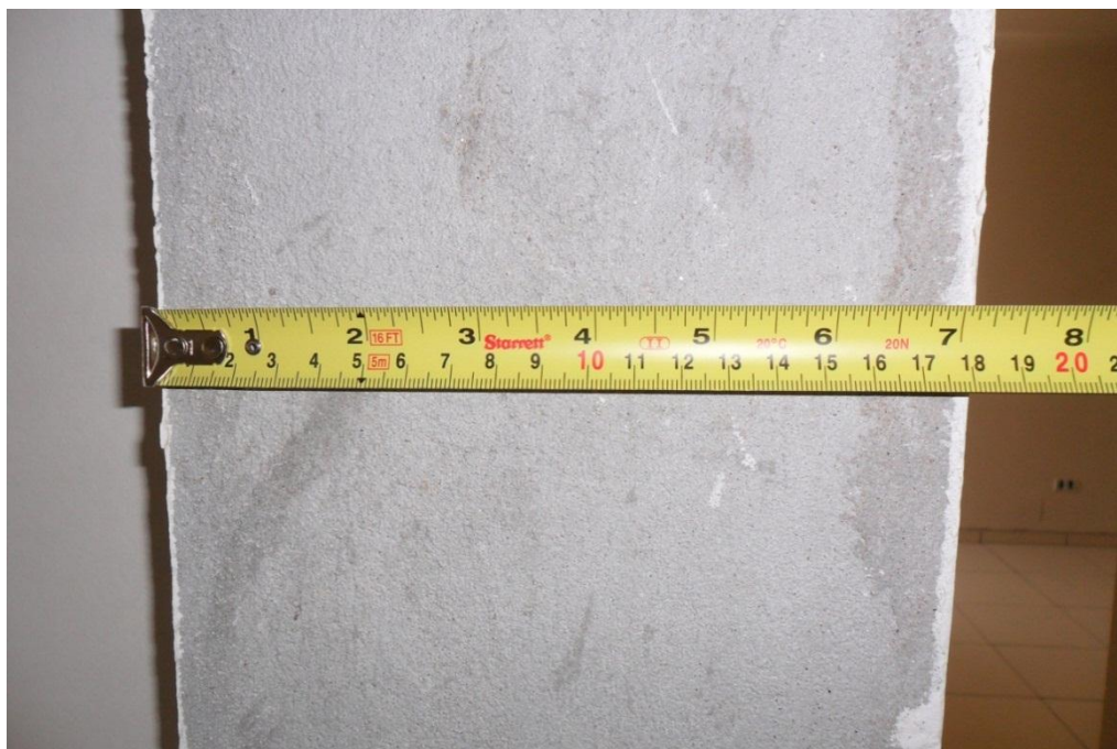
Figura 79 - Espessura da parede emboçada e rebocada (repetição da figura 15, utilizada nos resultados e discussões, p. 58)
