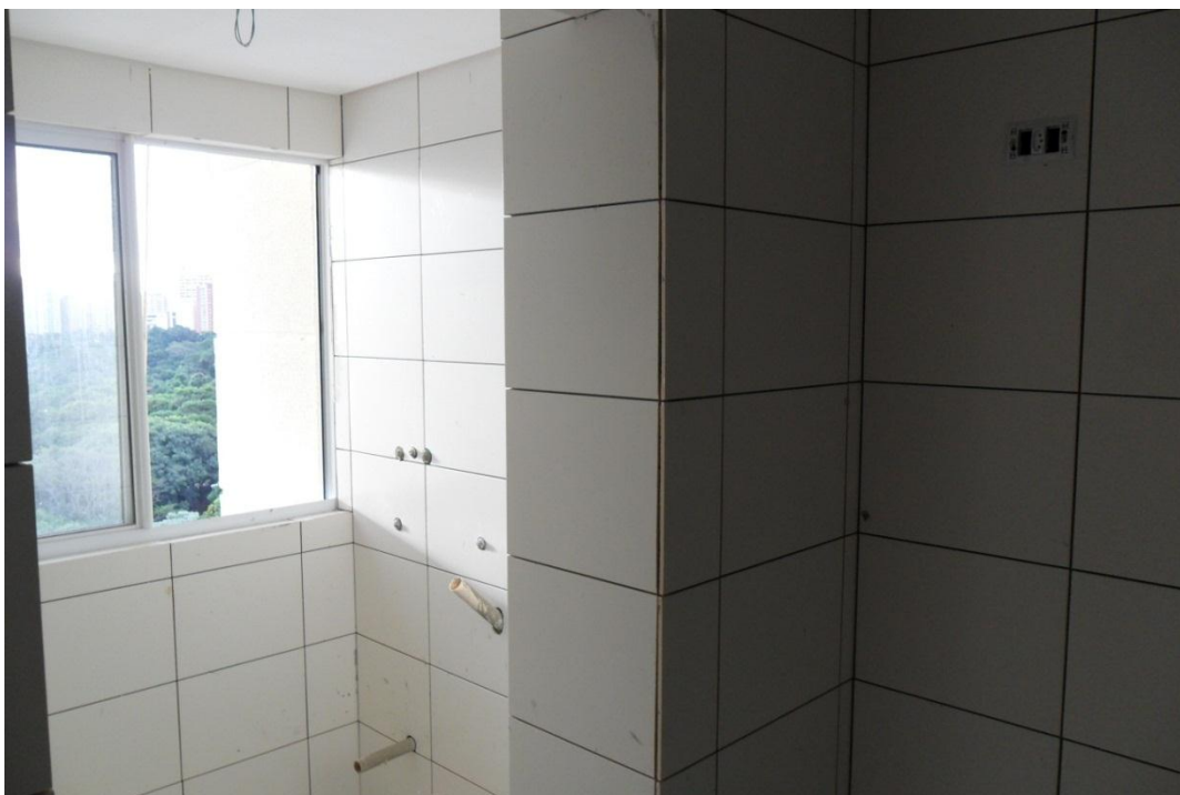
Figura 85 - Paredes entre cozinha e área de serviço
