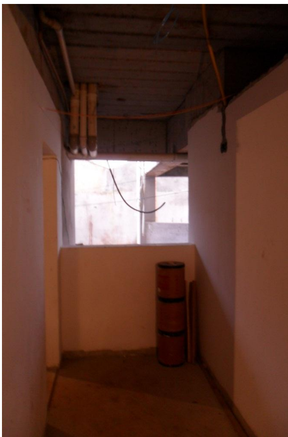
Figura 43 - Corredor de acesso à escadaria do subsolo
