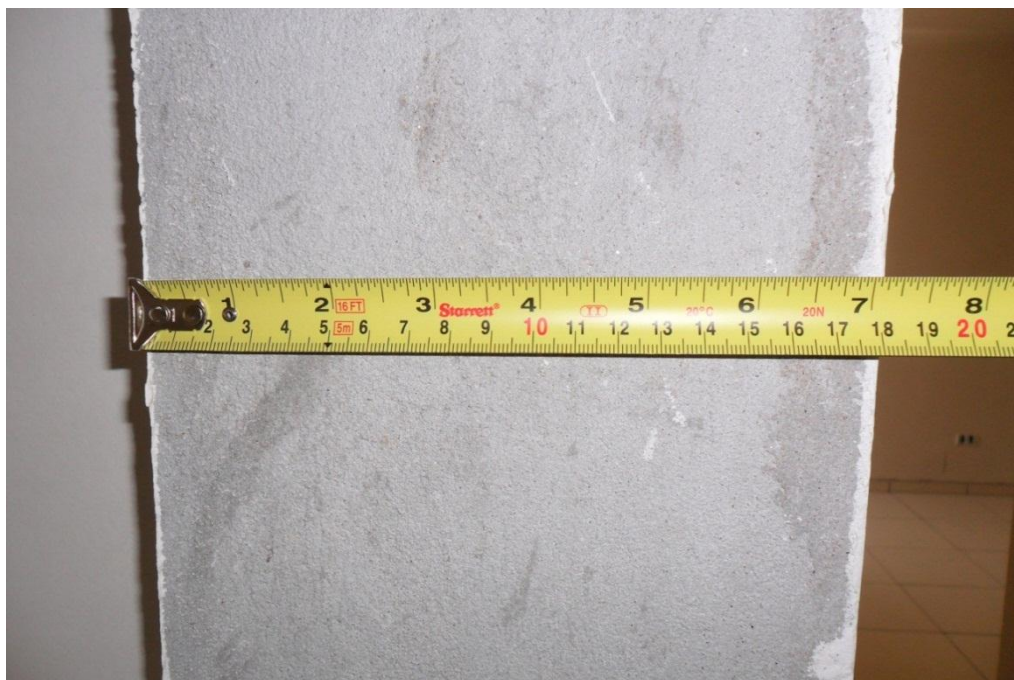
Figura 15 - Espessura da parede de blocos de concreto emboçada e rebocada.
