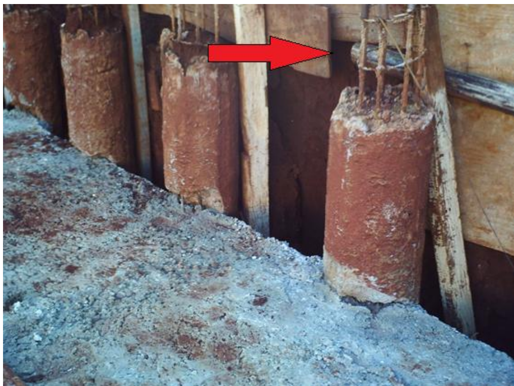
Figura 27 - Distância das estacas da contenção em relação à divisa do terreno (seta indica peças de madeira entra a estaca e o terreno vizinho) Fonte: Arquivo fornecido pela construtora.
