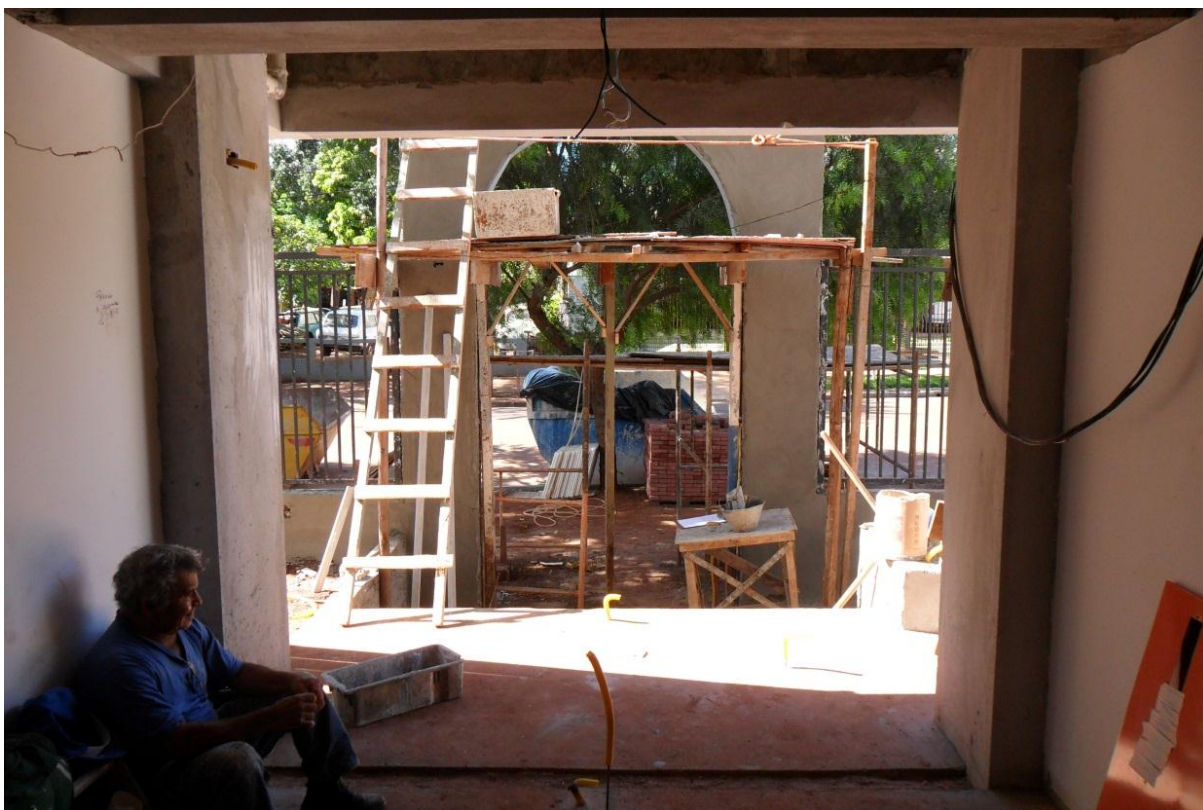
Figura 49 - Bonecas na entrada do hall vistas pelo lado de dentro (repetição da figura 14, utilizada nos resultados e discussões, p. 51)
