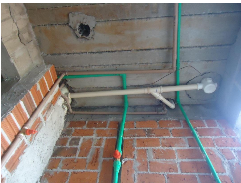
Figura 88 - Boneca sendo executada na parede atrás do tanque
