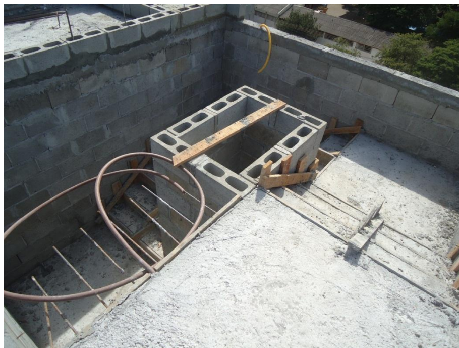
Figura 77 - Paredes no centro da escada enclausurada
