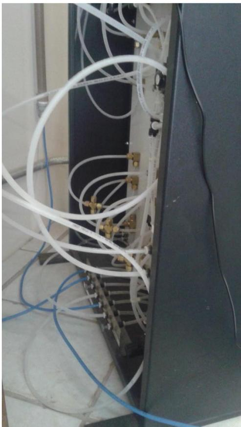
**Figura 87 – Conexões do verso do painel de controle.
