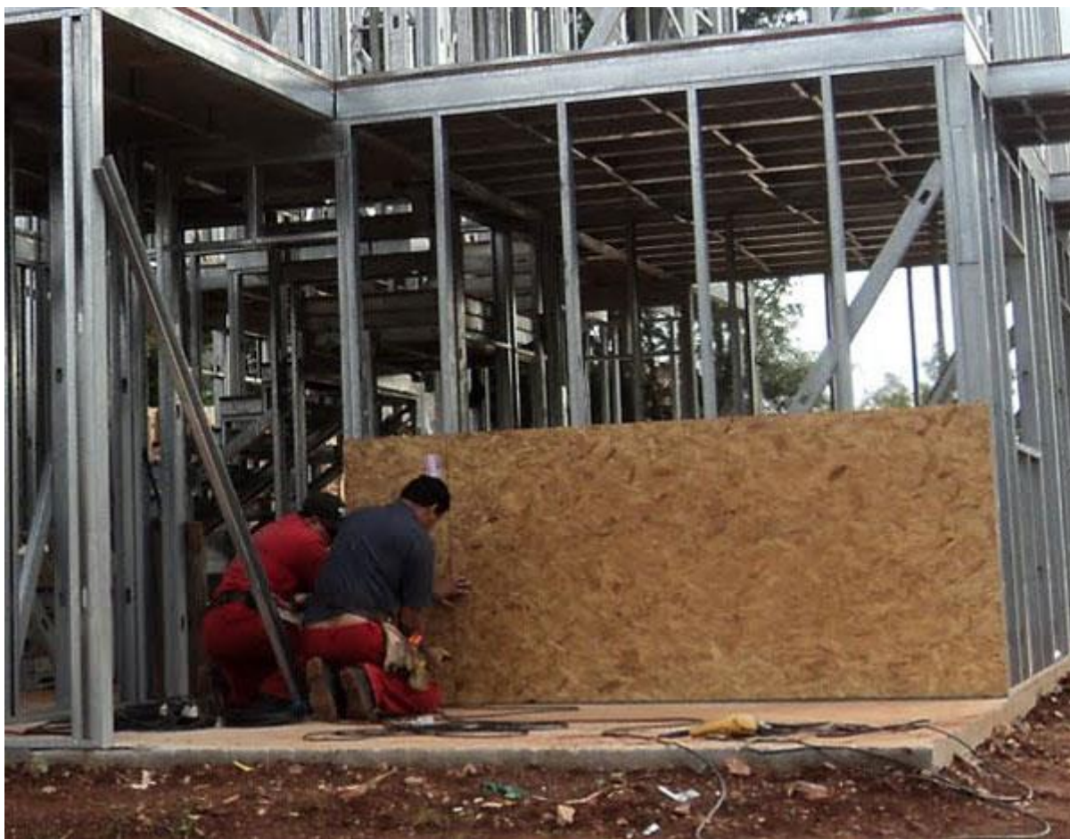
Figura 12 - Instalação de placas OSB Fonte: Espaços com Vida (2017)
