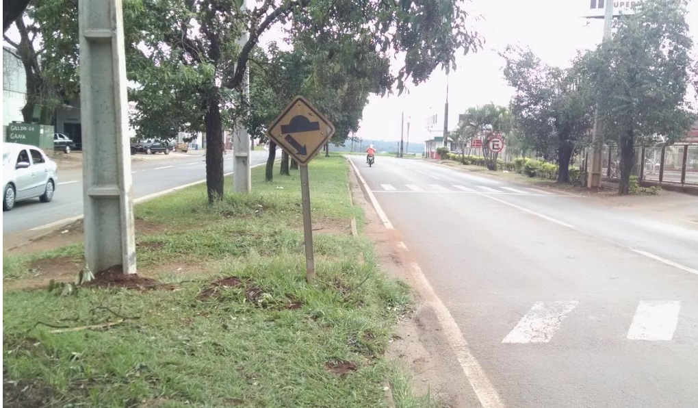
Figura 14 – Sinalização vertical fora de normal Fonte: Autoria própria (2016)
