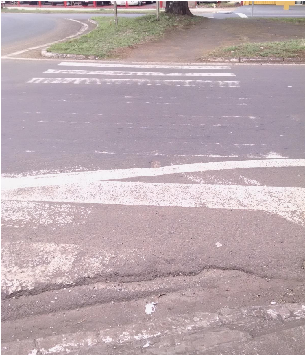
Figura 15 – Sinalização horizontal desgastada Fonte: Autoria própria (2016)
