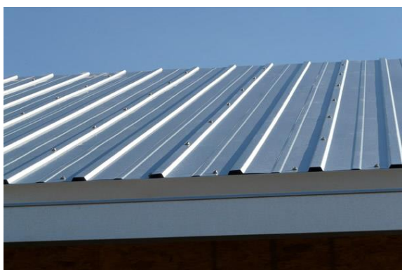
Figura 8 – Telhado de Zinco
