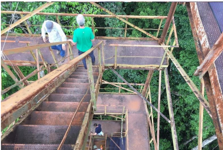
Figura 2 - Torre do INPA
