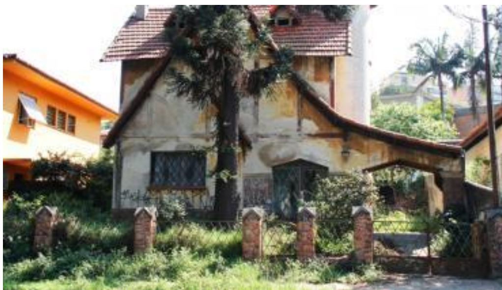
Fotografia 1 - Arquitetura colonial portuguesa, Rua dos Macunis – Vila Madalena.
