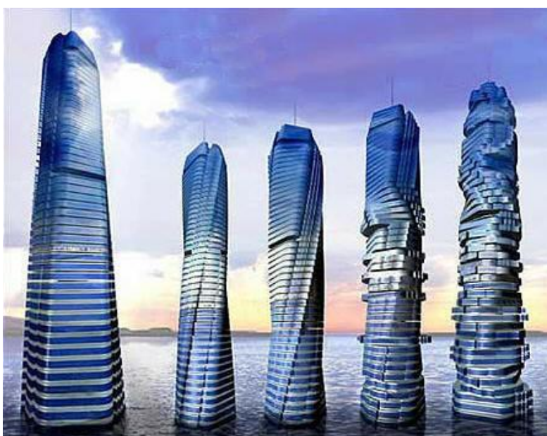
Figura 13: Torre rotativa em movimento
