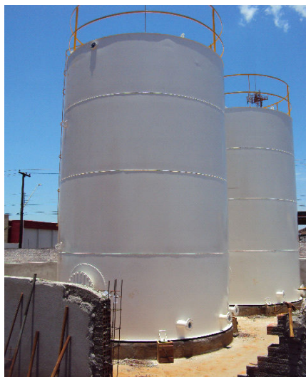
Figura 12 – Instalação de novos tanques.
