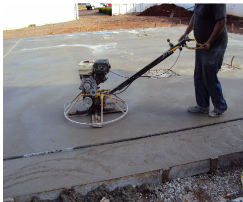
Figura 13 – Execução do piso da área de abastecimento.
