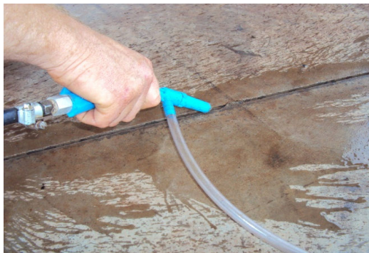
Figura 18 – Secagem do piso.
