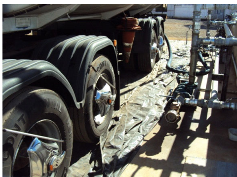
Figura 21 – Lona de proteção.
