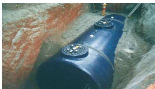
Figura 1 – Tanque enterrado. Fonte: BONAGURO (2004).
