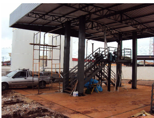
Figura 14 – Instalação da cobertura.
