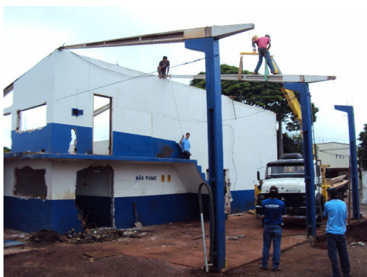
Figura 8 – Demolição da estrutura e cobertura metálica.
