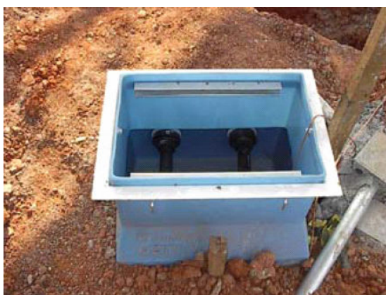
Figura 3 – Caixa separadora água óleo (SAO). Fonte: BONAGURO (2004).
