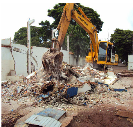
Figura 9 – Demolição da alvenaria.
