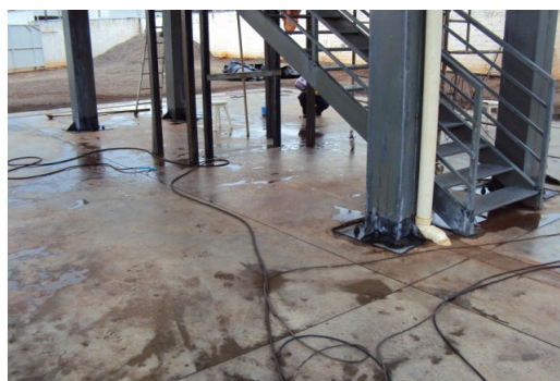
Figura 17 – Limpeza do piso.
