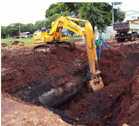
Figura 10 – Remoção dos tanques e solo.
