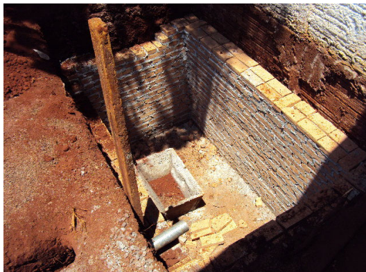
Figura 15 – Instalação da caixa coalescente
