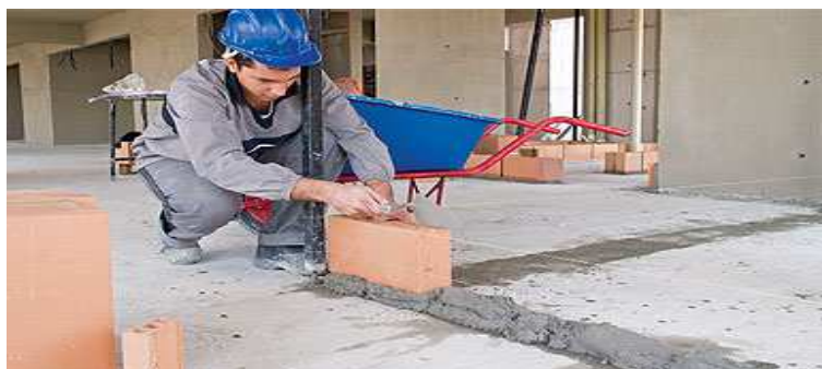
Figura 8: Marcação da 1ª fiada da alvenaria de vedação. Fonte: Bauer, 1994.
