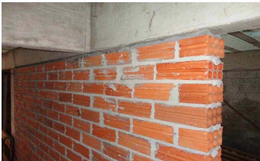
Figura 9: Detalhe do encunhamento da alvenaria.
