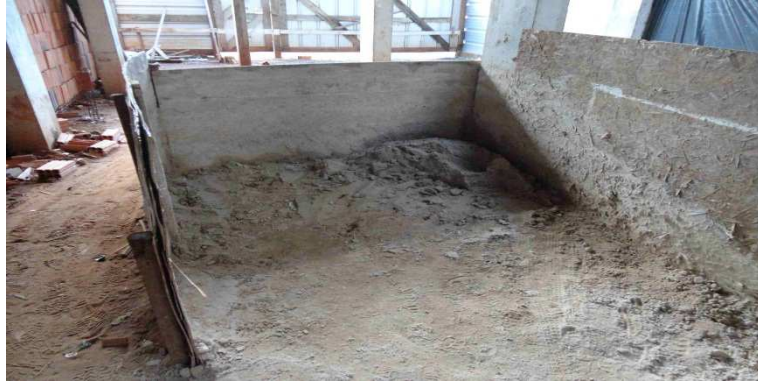
Figura 11: Recipiente da hidratação da argamassa.
