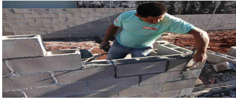
Figura 17: Assentamento dos Blocos.
