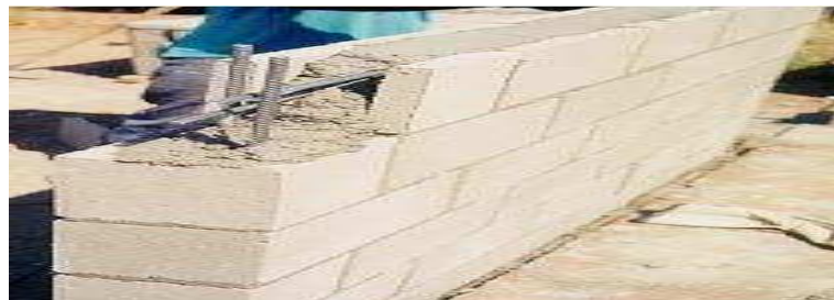
Figura 7: Enchimento de pilares e canaletas com graute.
