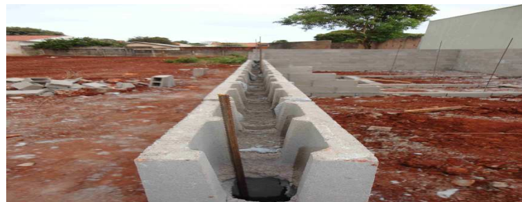
Figura 18: Detalhe da canaleta da janela sexta fiada.
