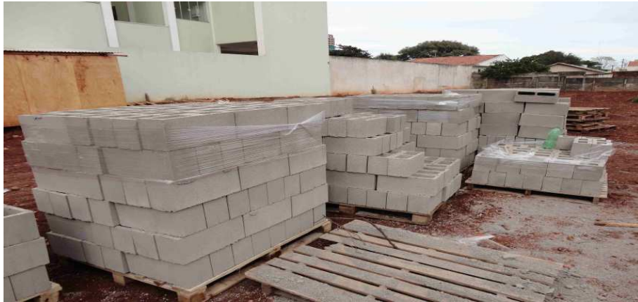
Figura 14: Blocos de concreto em paletes.
