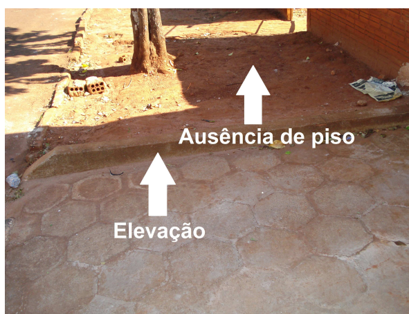
Figura 23: Obstáculo suspenso e ausência de piso no passeio. Fonte: Dados do Autor, 2012.
