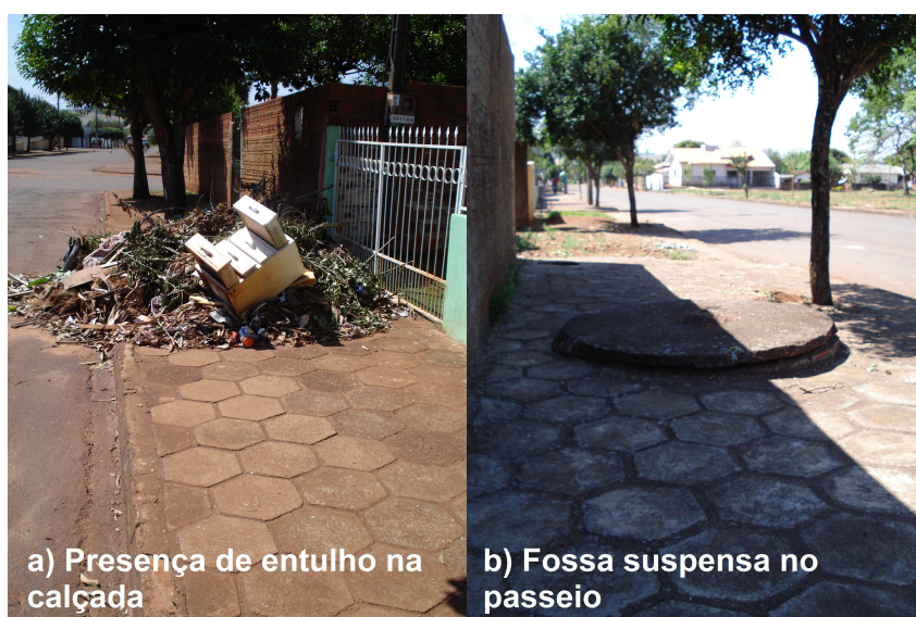
Figura 22: Obstrução do passeio por entulho e fossa suspensa. Fonte: Dados do Autor, 2012.
