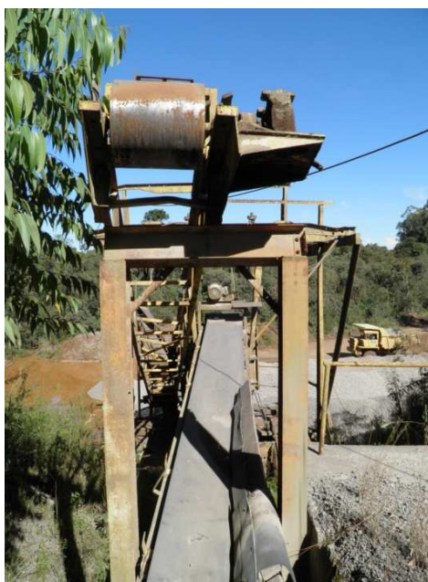
Figura 04: Esteira do Britador utilizado pela empresa A, localizada em Campo Mourão - Pr
