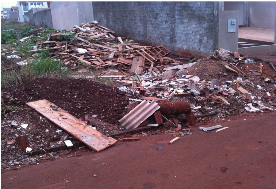
Figura 10: Resíduos da construção Civil depositados no Jd flora II em Campo Mourão, Paraná.
