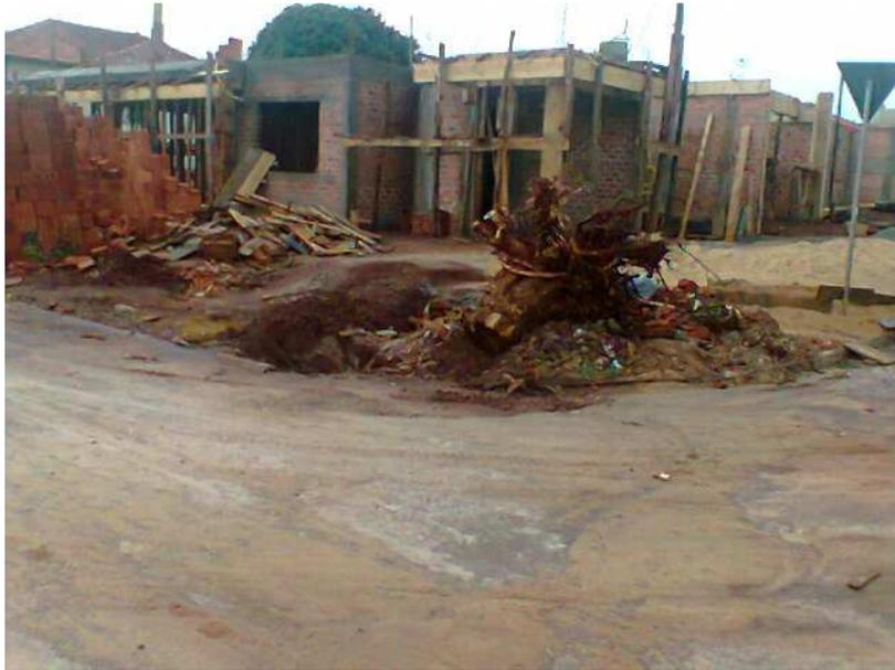
Figura 15: Fonte de riscos – não isolamento das proximidades da obra
