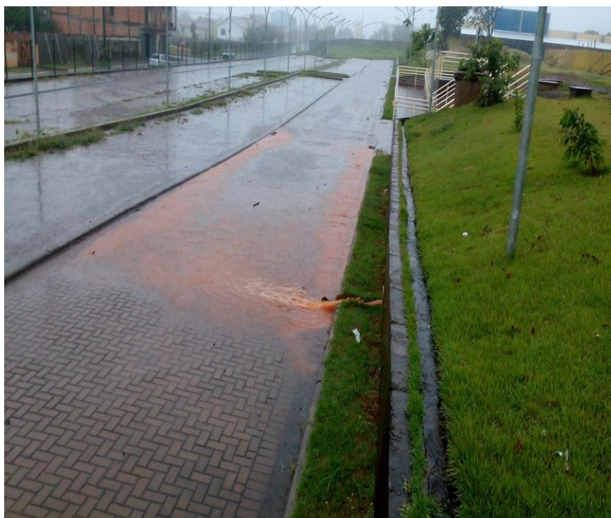
Figura 17: Problemas de sobrecarga no estacionamento inferior do campus
