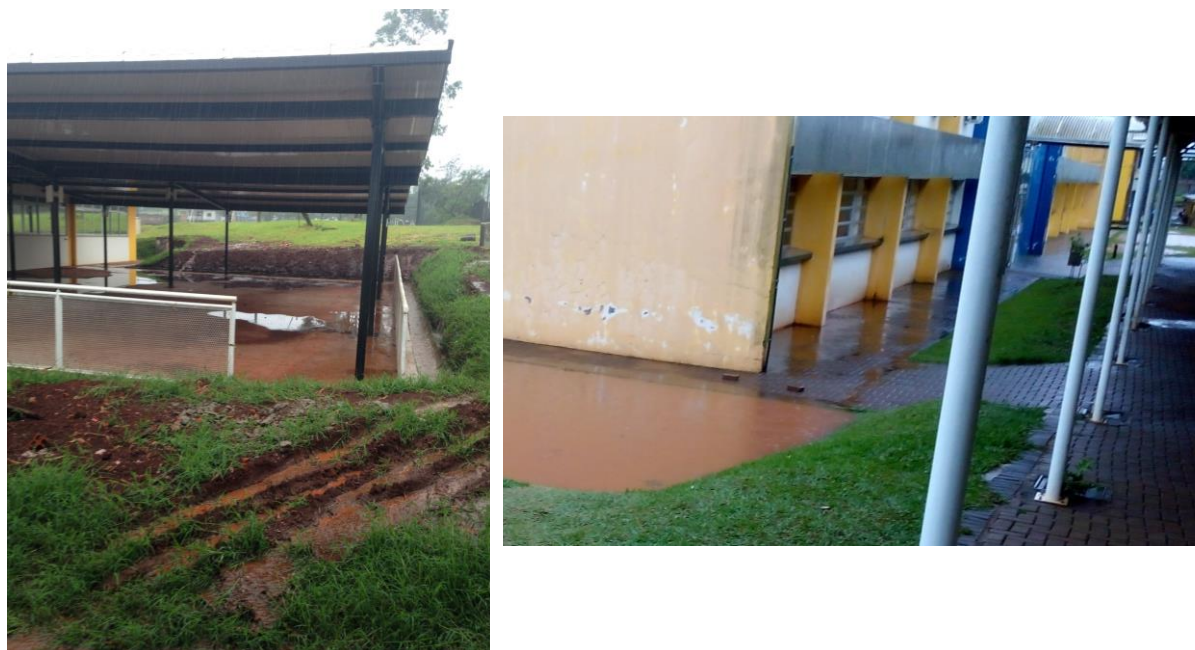
Figura 19: Registro de alagamento no campus em 2018
