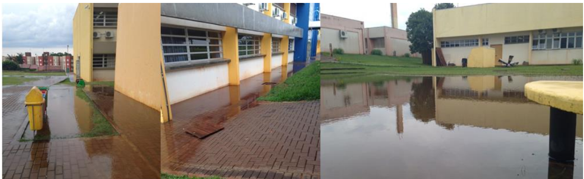
Figura 1: Inundação do campus
