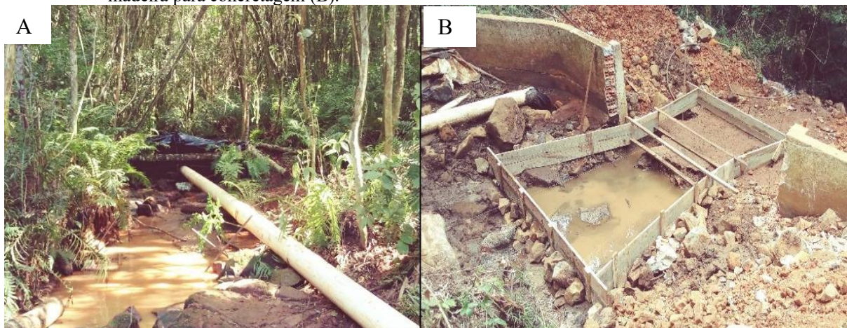
Figura 19 – Barramento e canalização do fluxo (A); retirada de vertedor triangular e construção de forma em madeira para concretagem (B).
