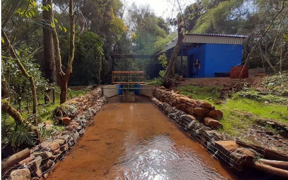
Figura 21 – Estação de monitoramento logo após construção.
