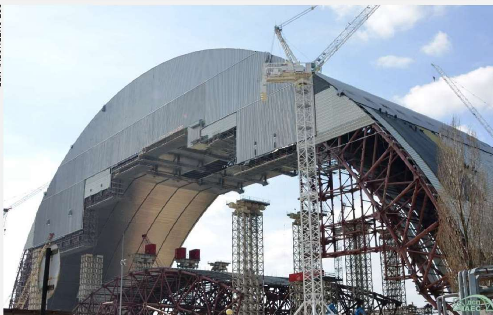
New Safe Confinement, foto construção em 2014 (parte externa)
