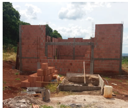
Nova construção da igreja "Assembleia de Deus", no Assentamento Eli Vive I
