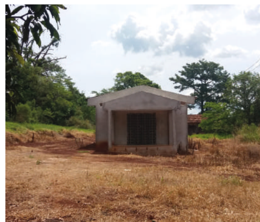
Nova construção de igreja católica, no Assentamento Eli Vive I
