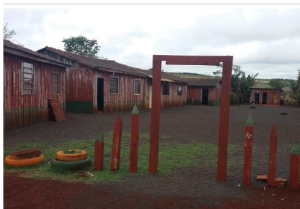
Escola Municipal do Campo Egídio Domingos Brunetto
