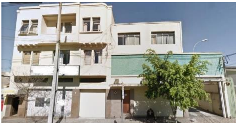
Figura 11 – Vista da fachada dos prédios
