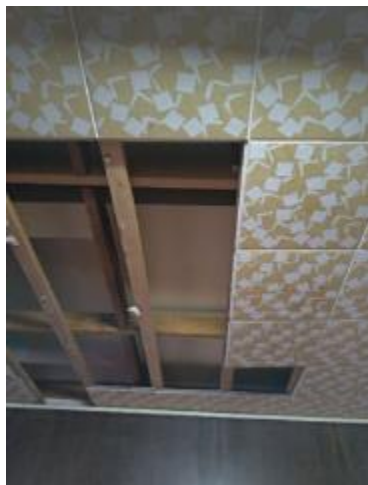
Figura 38 - Desconstrução de forro modular acartonado
