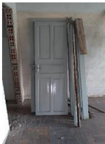
Figura 42 - Desconstrução de porta de madeira 80cm
