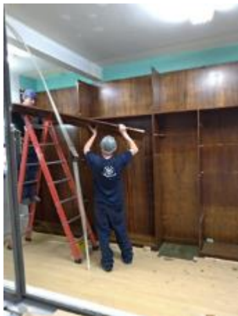
Figura 35 - Desmontagem manual de armário de madeira
