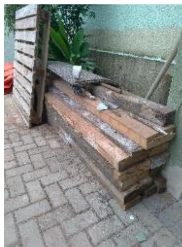
Figura 72 - Vigas de madeira do telhado e mezanino separadas para reutilização no local como escoramento
