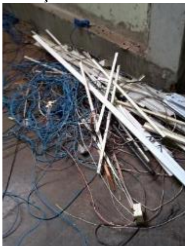
Figura 37 - Desmontagem de conduítes aparentes e fiação
