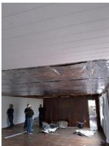
Figura 43 - Desmontagem de forro de PVC
