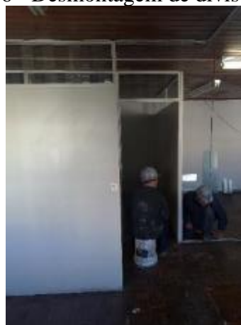
Figura 36 - Desmontagem de divisória naval
