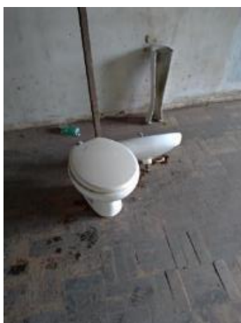
Figura 45 - Vaso sanitário e lavatório de coluna desmontados
