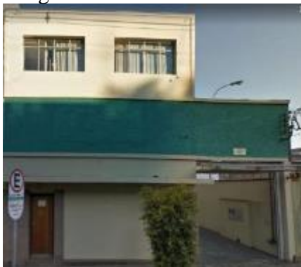
Figura 29 - Fachada Prédio B
