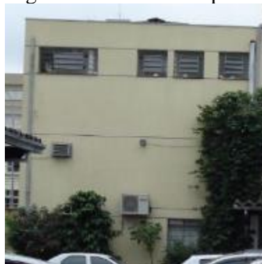
Figura 31 - Fundos do prédio
