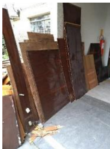
Figura 50 - Chapas de revestimento de madeira separadas
