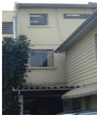
Figura 25 - Entrada dos fundos do prédio
