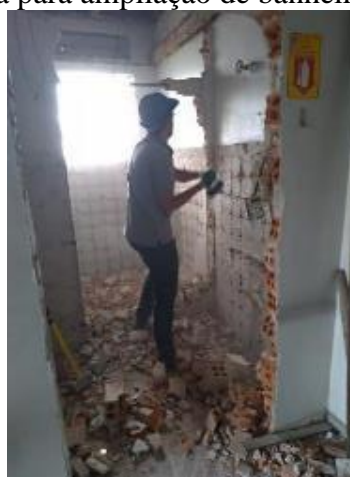
Figura 44 - Demolição destrutiva de parede de alvenaria para ampliação de banheiro
