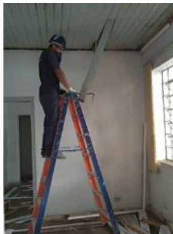
Figura 40 - Demolição destrutiva de forro de madeira
