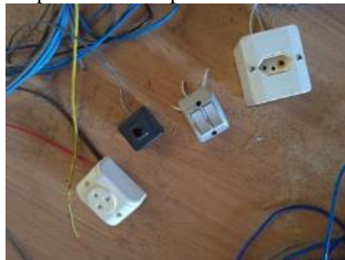
Figura 39 - Desmontagem de tomadas e interruptores de sobrepor
