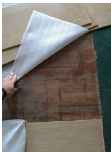
Figura 61 - Reutilização de piso de tacos que estava embaixo de 2 camadas de piso: carpete e piso lamindado
