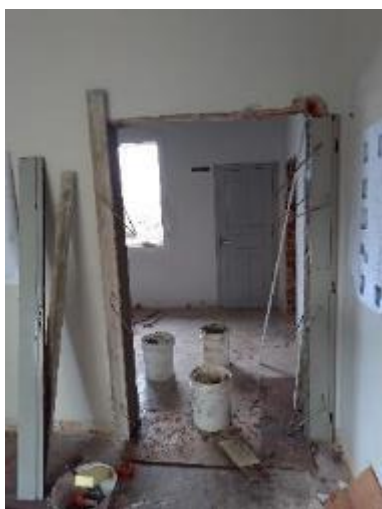
Figura 71 - Batentes e vistas de portas de madeira reutilizados no local como fôrma para requadro de paredes e vãos
