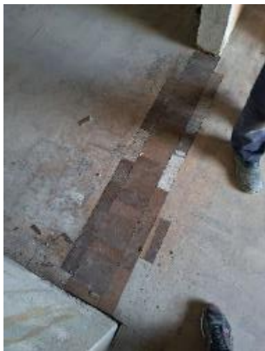
Figura 69 - Tacos de madeira reutilizados no local
