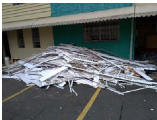
Figura 62 - Réguas danificadas de forro de PVC separadas para reaproveitamento em usina de reciclagem
