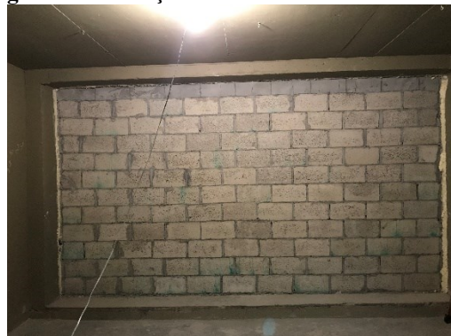
Figura 32– Vedação vertical de blocos com RCD.
