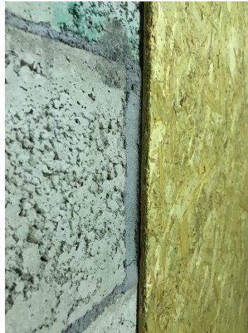
Figura 34– Painel fixado na vedação de blocos.
