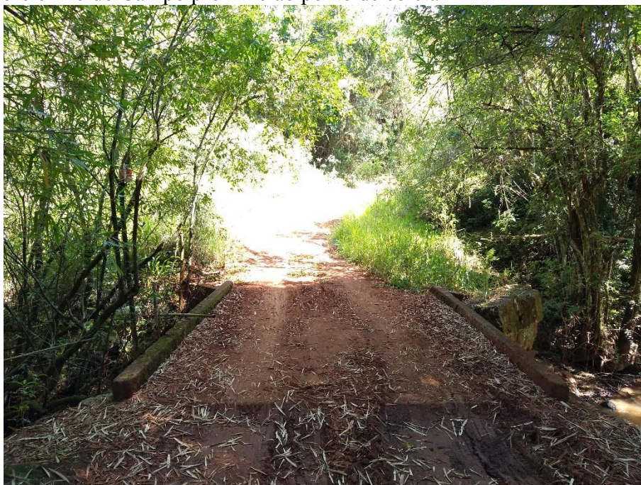
Ponte sobre o Rio do Campo próximo ao ponto de coleta P1
