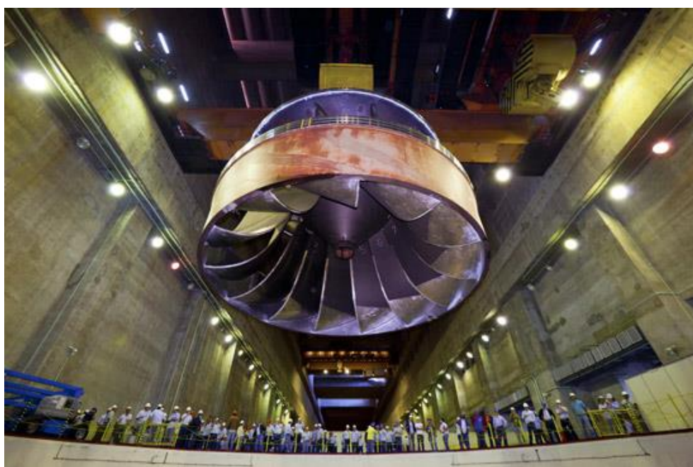
Figura 2 - Rotor Francis da turbina hidráulica de Itaipu fabricada em aço CA6NM Fonte: Jornal De Itaipu Eletrônico (2011)
