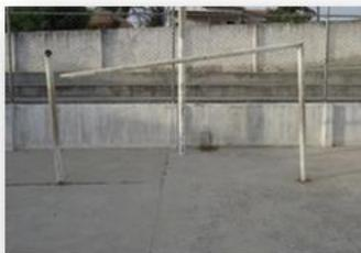
**1 Qualidade Regular:** falta asfalto/cimento em algum local e existem poucos buracos, rachaduras, desníveis ou falta demarcação de linhas. As linhas e traves apresentam desgaste na pintura. Não existe rede na trave ou a rede está rasgada.
