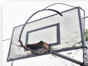
**1 Qualidade Regular:** falta asfalto/cimento em algum local e existem poucos buracos, rachaduras, desníveis ou falta demarcação de linhas. As linhas, tabelas e aros apresentam desgaste na pintura. Não existe rede no aro.
