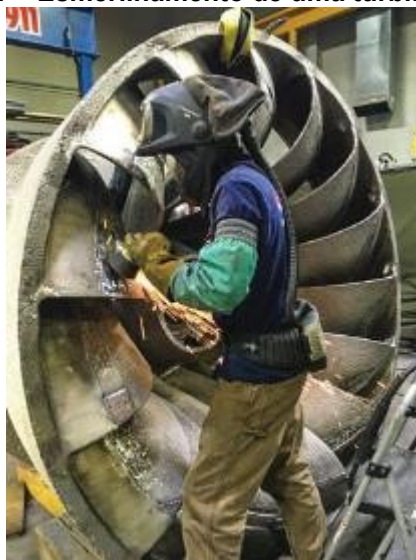
Fotografia 1 – Esmerilhamento de uma turbina hidráulica
