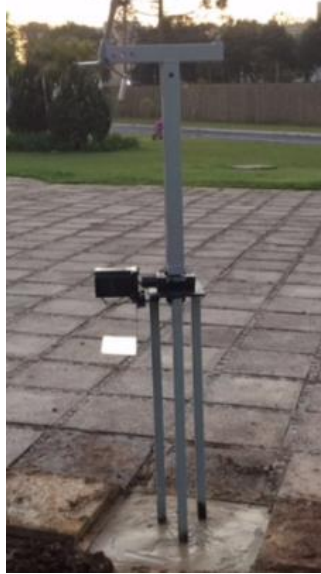
Figura 43 - Instalação da estrutura mecânica no solo
