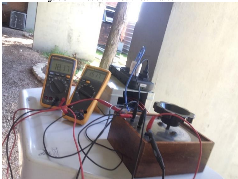
Figura 52 - Ensaio do módulo fotovoltaico
