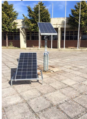
Figura 46 - Instalação do módulo fixo ao lado do seguidor
