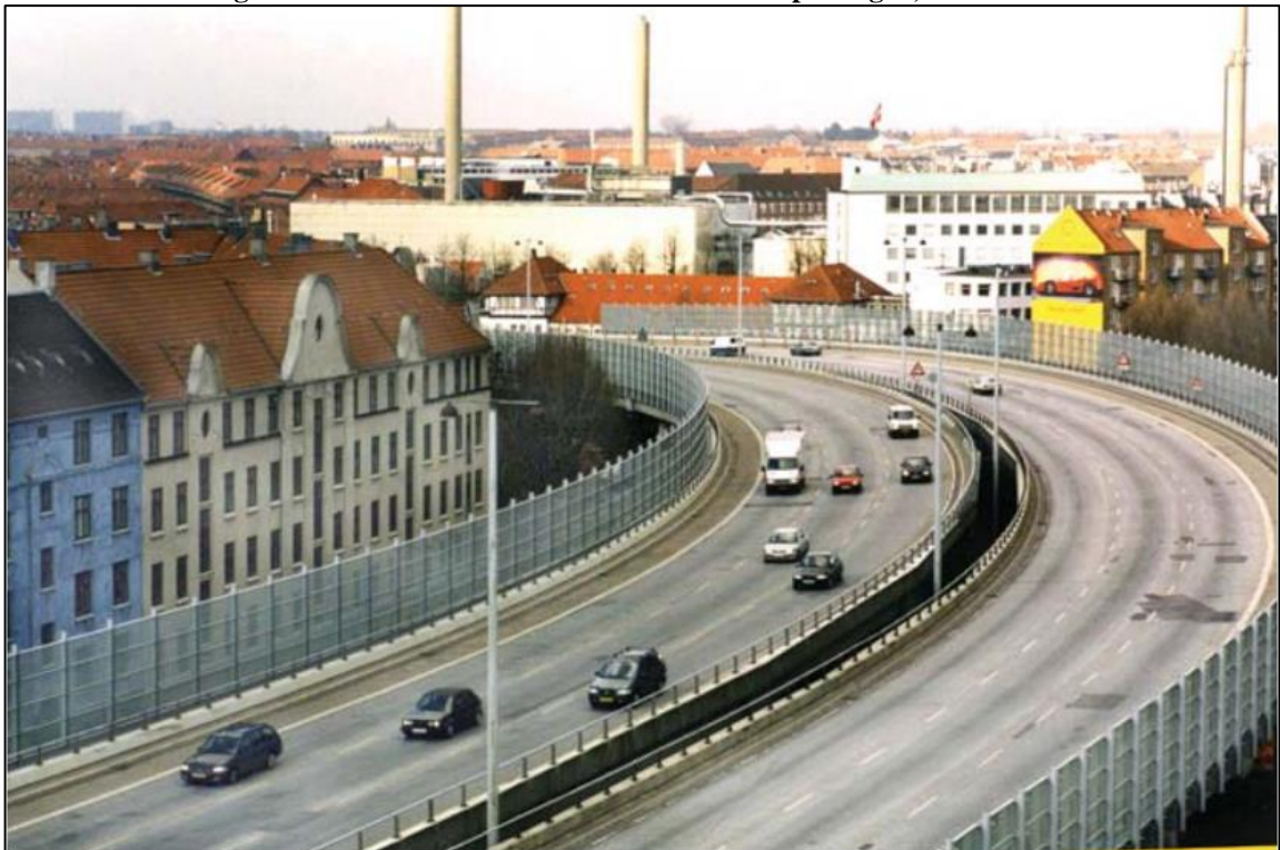
Figura 24 – Barreira acústica instalada em Copenhague, Dinamarca.
