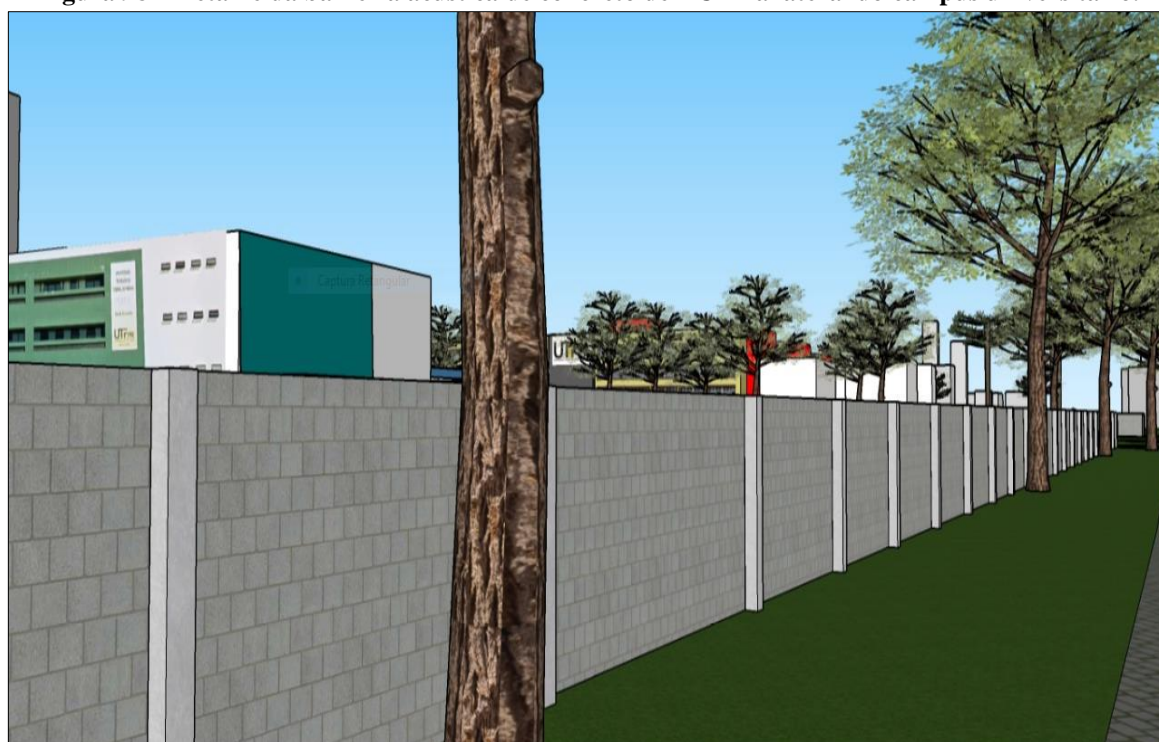
Figura 98 – Detalhe da barreira acústica de concreto de RCD na lateral do câmpus universitário.
