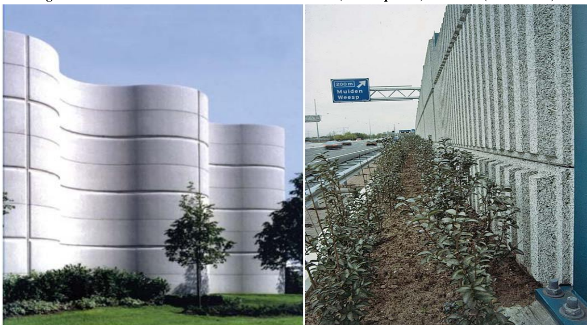
Figura 27 – Barreira de concreto. Perfis na horizontal (lado esquerdo) e vertical (lado direito).
