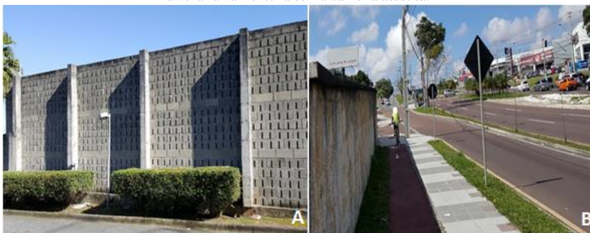
Figura 45 – Barreira acústica de um cenário real. A) Barreira acústica de bloco de concreto. B) Muro de alvenaria na fronteira com a barreira acústica.
