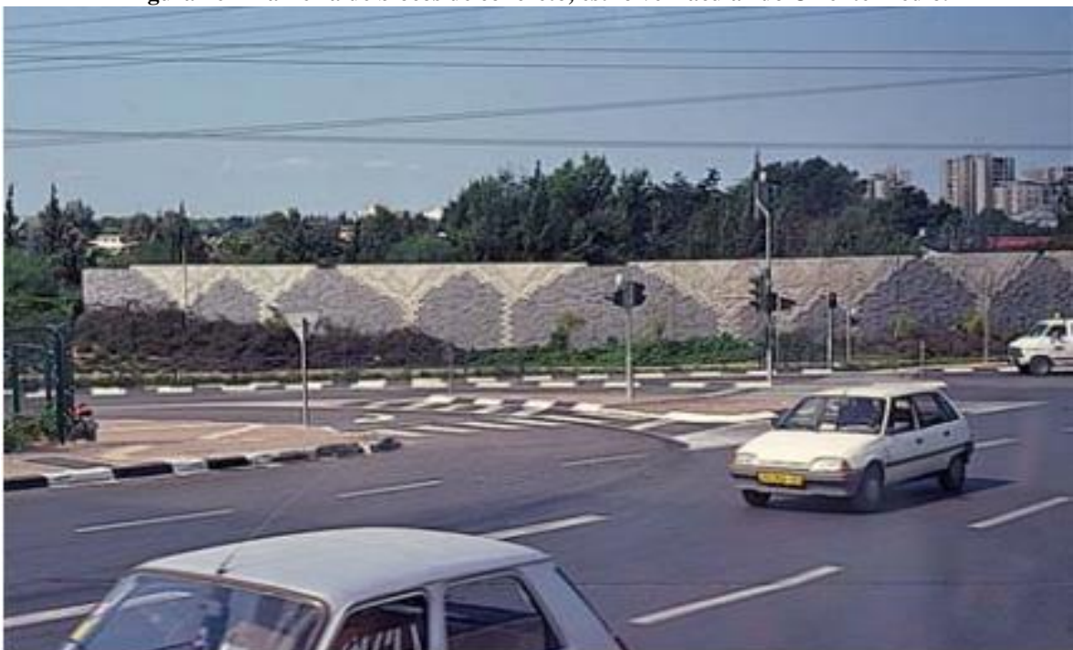
Figura 26 – Barreira de blocos de concreto, estilo vernacular do Oriente Médio.
