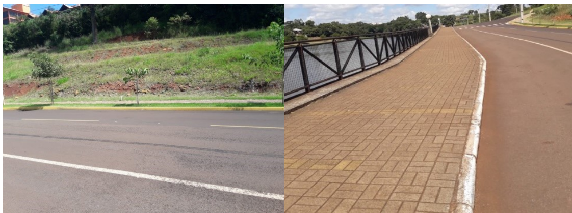
Figura 42: Calçadas Loteamento Portal do Lago
