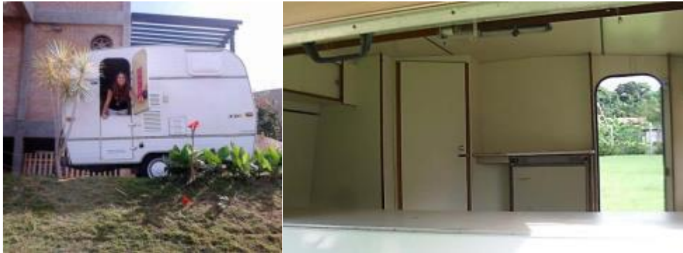
Figura 116: O trailer antes da reforma.
