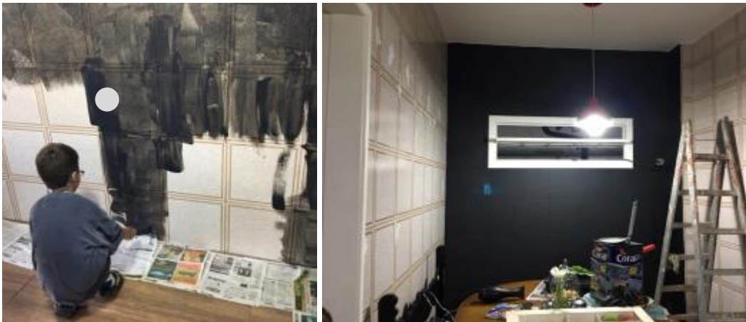
Figura 112: As etapas de pintura das paredes da cozinha.
