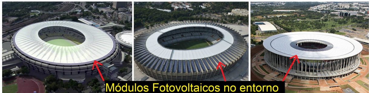
Figura 3: Módulos fotovoltaicos instalados no Maracanã, Mineirão e Mané Garrincha.
