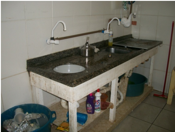
Figura 156 - Refeitório sem Limpeza, arejamento e boa iluminação - Obra G. Fonte: O autor (2018)
