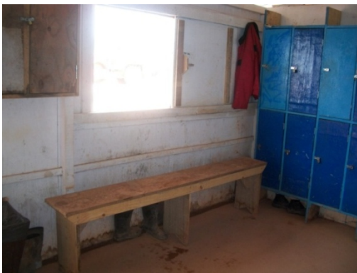
Figura 51 - Vestiário - Obra A. Fonte: O autor (2016)
