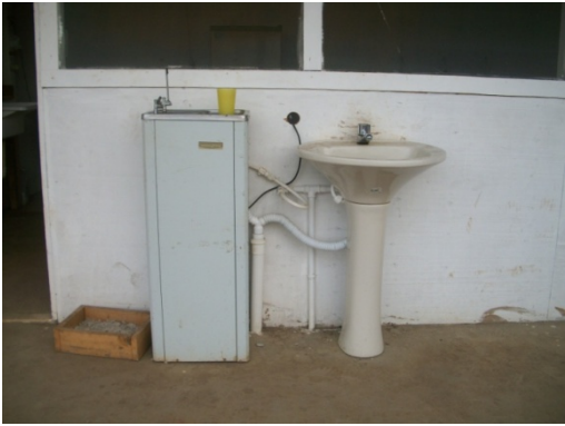
Figura 76 24- Uso de copos coletivamente - Obra A. Fonte: O autor (2018)
