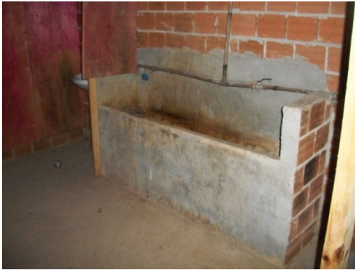
Figura 34 - Instalações Sanitárias - Obra A. Fonte: O autor (2016)
