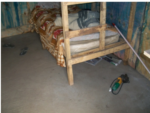
Figura 94 25- O alojamento deve ser mantido em permanente estado de conservação, higiene e limpeza - Obra F.
