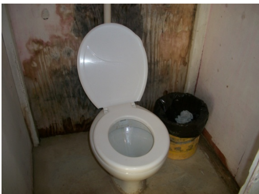
Figura 101 - As instalações sanitárias devem ser mantidas em processos constantes de higienização - Obra B.
