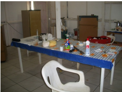
Figura 73 - Local para refeições sem lavatório instalado em suas proximidades ou no seu interior - Obra G.
