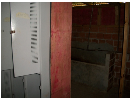
Figura 2818 - Instalações sanitárias com pouca iluminação - Obra C. Fonte: O autor (2018)
