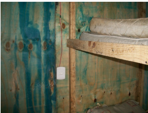
Figura 91 - Cama com dimensões inferiores ao especificado na legislação - Obra F. Fonte: O autor (2018)
