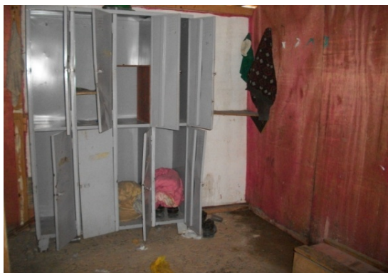
Figura 138 - Vestiário com armários com compartimentos simples - Obra A. Fonte: O autor (2018)
