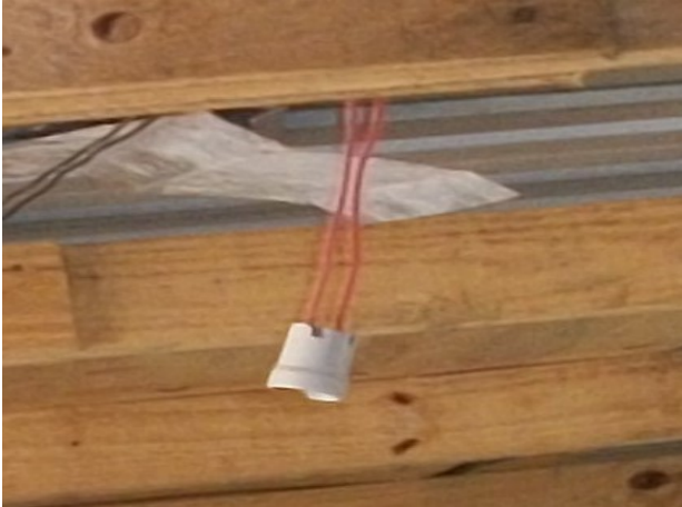
Figura 152 - Refeitório sem lâmpadas incandescentes de 150 W/m 2 - Obra E. Fonte: O autor (2018)
