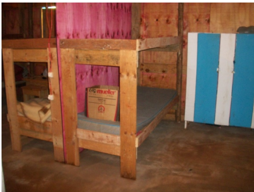
Figura 88 - Alojamento com instalações elétricas desprotegidas e sem armários duplos individuais e não estão sendo mantidos em permanente estado de conservação, higiene e limpeza (ambiente empoeirando) - Obra E. Fonte: O autor (2018)
