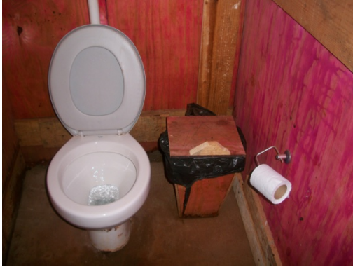
Figura 18 - Instalações sanitárias não estão sendo mantidas em perfeito estado de conservação e higiene - Obra E. Fonte: O autor (2018)
