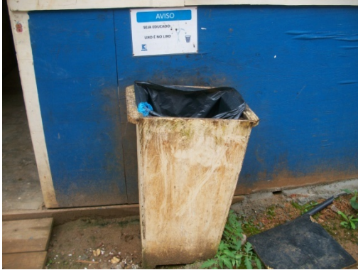
Figura 66 - Refeitório deve ter depósito, com tampa, para detritos - Obra C. Fonte: O autor (2018)
