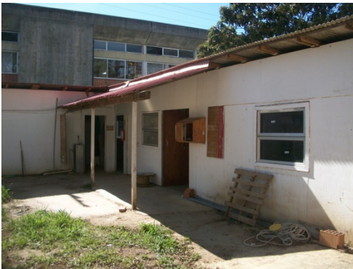
Figura 64 - Refeitório não contém lavatório para lavagem das mãos no momento das refeições e possuem comunicação direta com as instalações sanitárias - Obra B. Fonte: O autor (2018)
