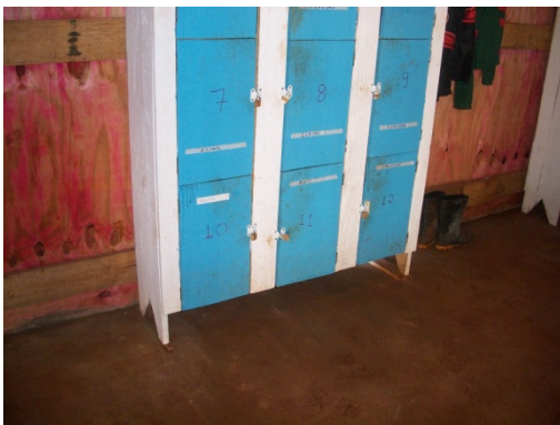
Figura 57 - Vestiário com falta de conservação, higiene e limpeza e não existem bancos para troca de roupas - Obra E. Fonte: O autor (2018)
