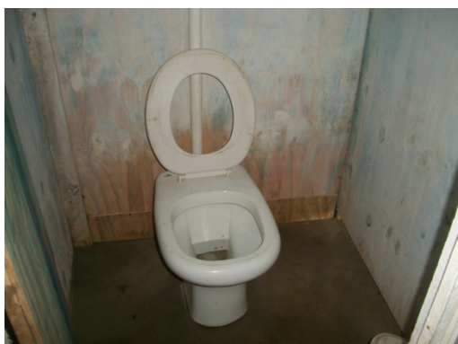
Figura 125 - Gabinete sanitário sem asseio e higiene - Obra F. Fonte: O autor (2018)
