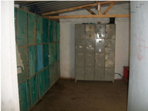
Figura 58 - Vestiário não tem uma área de ventilação correspondente a 1/10 (um décimo) de área do piso - Obra F.
