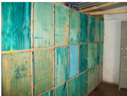
Figura 92 - Alojamento sem armários duplo com as dimensões corretas - Obra F. Fonte: O autor (2018)
