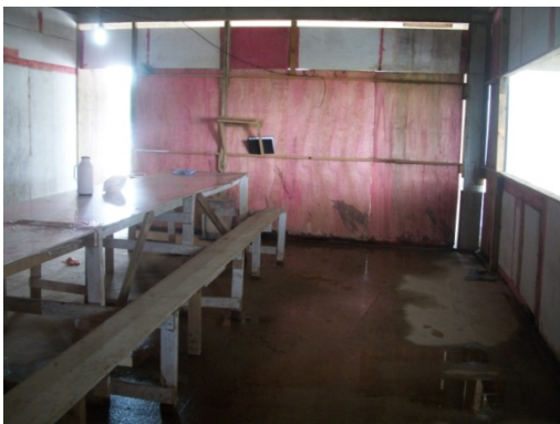
Figura 63 19- Local para refeições localizado em subsolos - Obra A. Fonte: O autor (2018)
