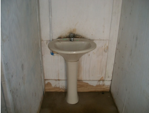
Figura 31 - Lavatório deve ser individual ou coletivo, tipo calha - Obra F. Fonte: O autor (2018)
