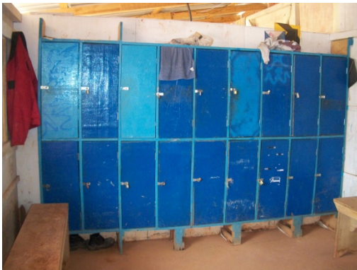
Figura 141 - Armários fora do padrão especificado pela legislação - Obra D. Fonte: O autor (2018)
