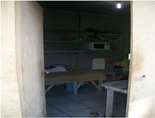
Figura 167 - Alojamento com o pé-direito com dimensões mínimas inferiores de 2,6m para camas simples - Obra G. Fonte: O autor (2018)
