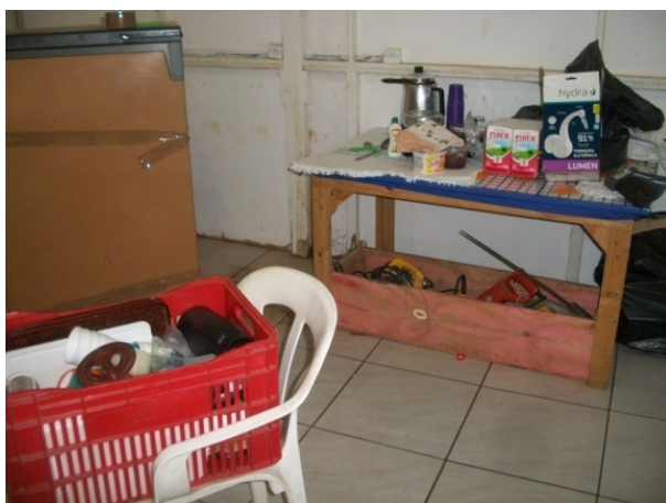
Figura 154 - Refeitório sendo utilizado como depósito de ferramentas - Obra G. Fonte: O autor (2018)
