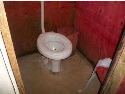
Figura 14 - Instalações Sanitárias - Obra C Fonte: O autor (2018)
