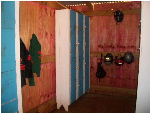
Figura 56 - Vestiário sem ventilação e iluminação - Obra E. Fonte: O autor (2018)
