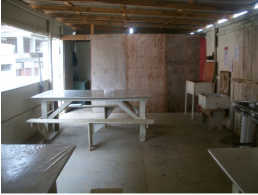
Figura 147 32- Refeitório com ambiente escuro - Obra C. Fonte: O autor (2018)
