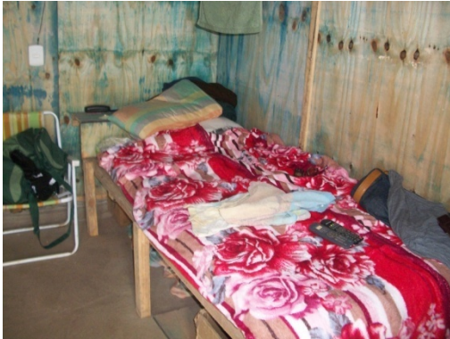
Figura 162 - Alojamento não possui pé-direito de 2,6m para camas simples - Obra F. Fonte: O autor (2018)
