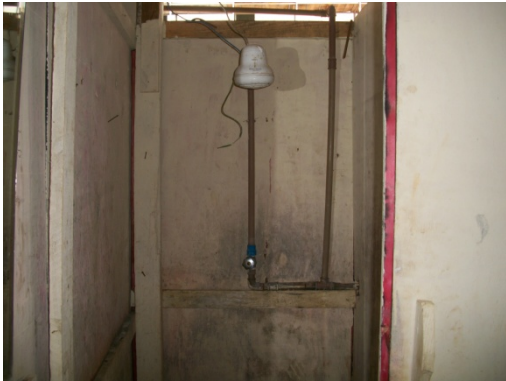
Figura 110 - Instalações sanitárias sem conservação e higiene e sem portas - Obra C. Fonte: O autor (2018)
