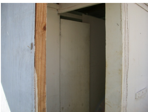
Figura 130 - Vestiário com paredes de madeira - Obra B. Fonte: O autor (2018)
