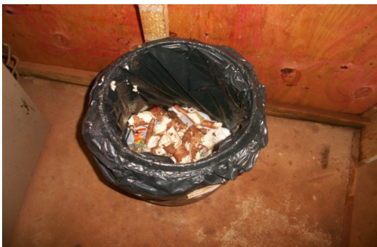
Figura 83 - Cozinha não dispõe de recipiente, com tampa, para coleta de lixo - Obra E. Fonte: O autor (2018)
