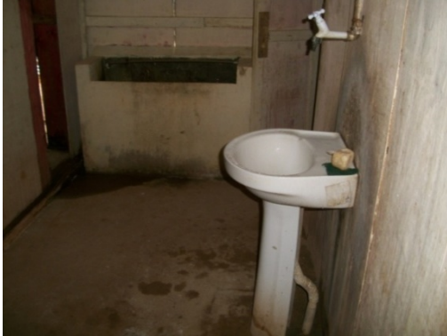
Figura 2713 - Lavatórios - Obra C. Fonte: O autor (2018)
