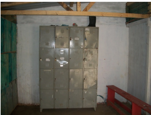
Figura 142 - Vestiário sem armários com compartimentos duplos - Obra F. Fonte: O autor (2018)
