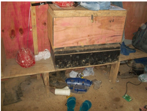
Figura 181 - Vestiário sem conservação, higiene e limpeza e com bancos em número insuficiente para atender aos usuários, com largura inferior a 0,30m (trinta centímetros) - Obra G. Fonte: O autor (2018)
