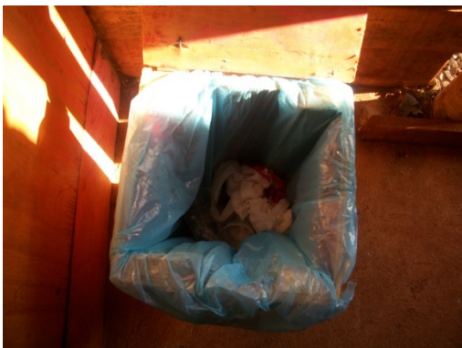
Figura 165 - O lixo do alojamento deverá ser retirado diariamente e depositado em local adequado - Obra F. Fonte: O autor (2018)
