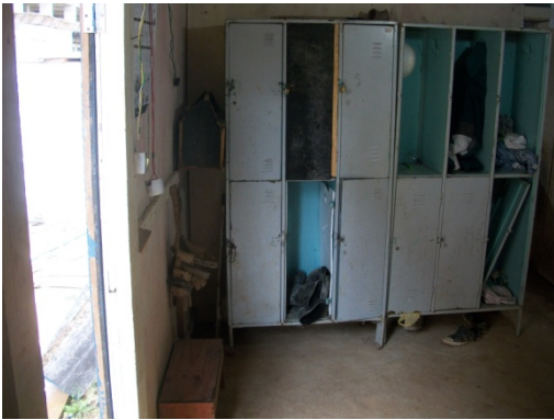
Figura 53 - Vestiário sem estar em perfeito estado de conservação, higiene e limpeza - Obra C. Fonte: O autor (2018)
