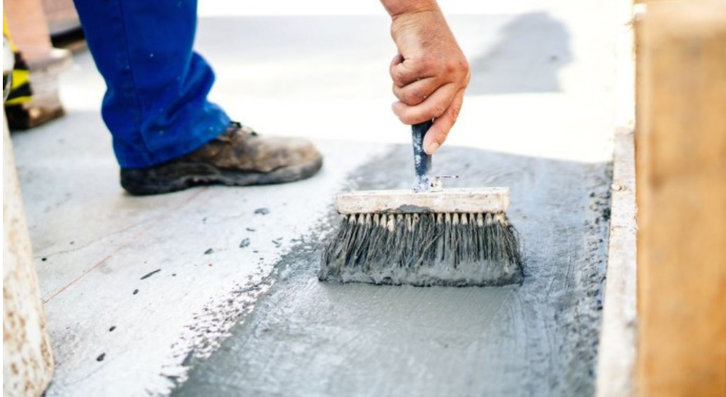
Figura 2 - Aplicação de argamassa polimérica sob forma de pintura
