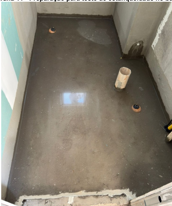
Fotografia 11 - Preparação para teste de estanqueidade no banheiro
