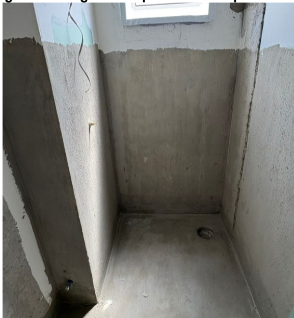
Fotografia 6 - Argamassa polimérica na parede do box
