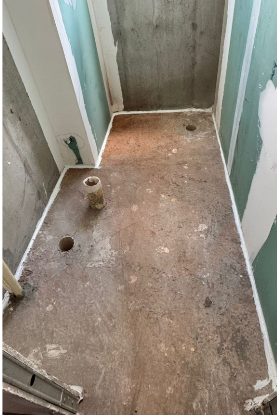
Fotografia 2 -Aplicação de PU em parede drywall no banheiro
