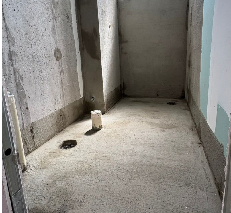
Fotografia 7 - Argamassa polimérica na parede do banheiro
