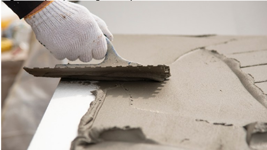
Figura 3 - Aplicação de argamassa polimérica sob forma de revestimento
