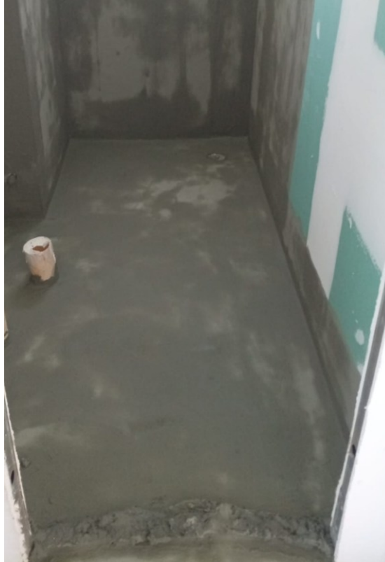
Fotografia 10 - 2ª demão de argamassa polimérica no banheiro
