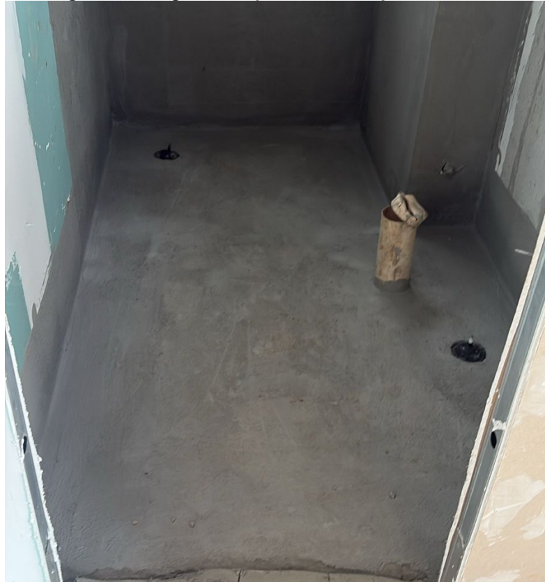
Fotografia 9 - Argamassa polimérica no piso do banheiro
