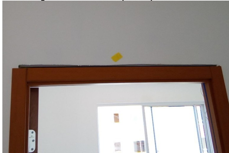
Fotografia 34 – Vão entre porta e parede
