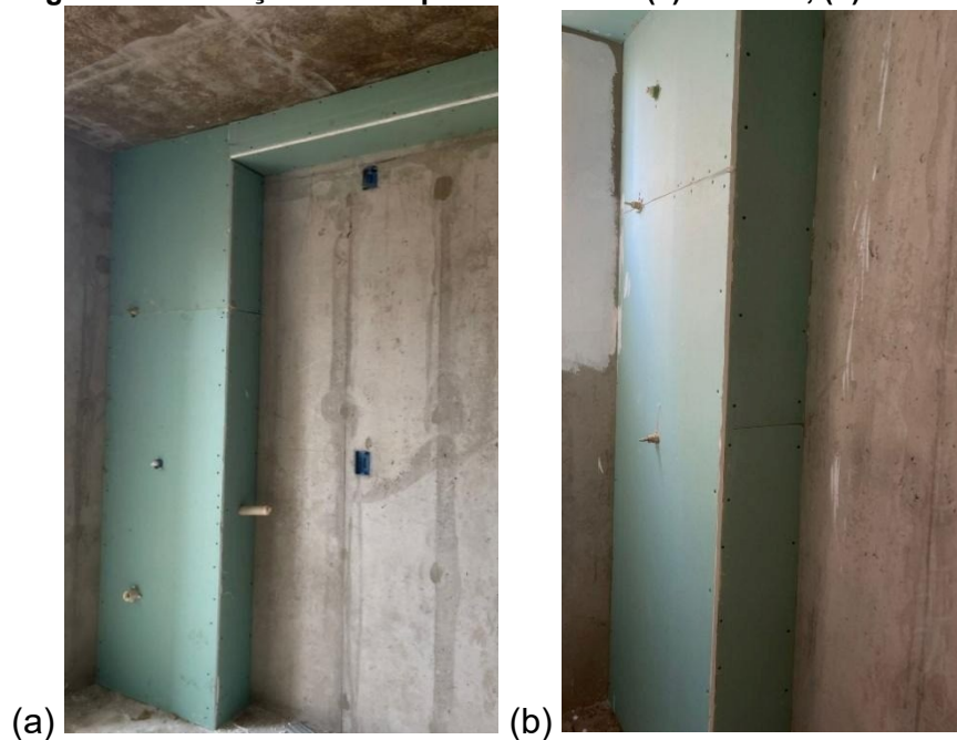
Fotografia 10 - Fixação das chapas nos shafts: (a) Cozinha; (b) Banheiro
