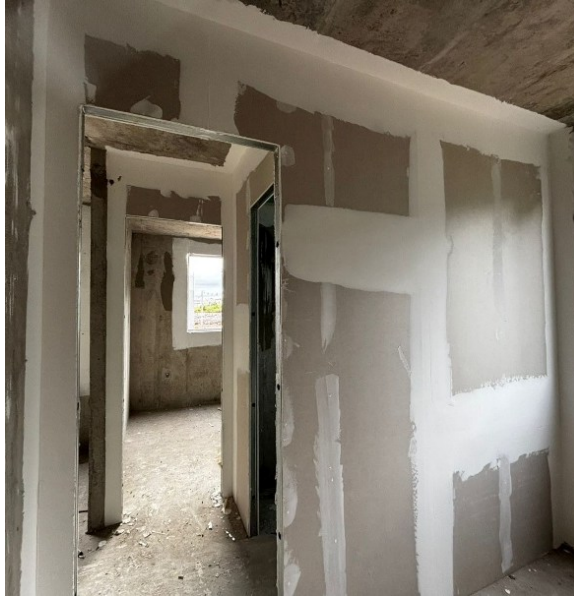
Fotografia 14 - Aplicação segunda demão de massa e fita na parede do quarto
