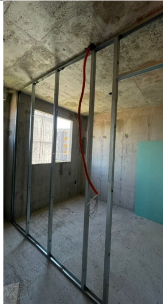
Fotografia 5 - Fixação dos montantes
