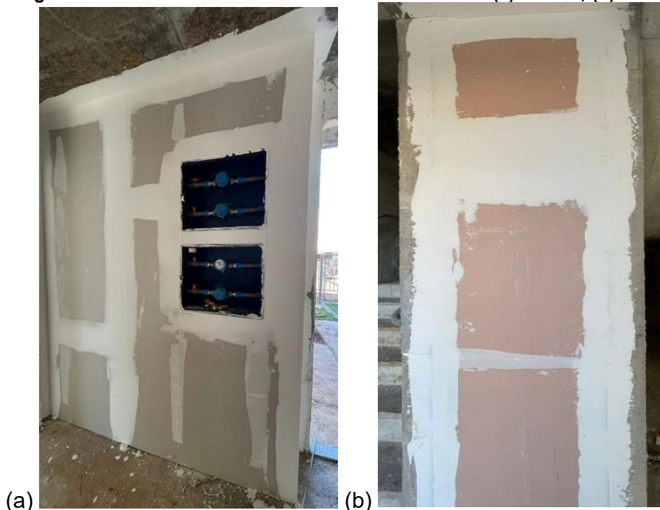
Fotografia 18 – Acabamento final das divisórias no hall : (a) Vista 1; (b) Vista 2
