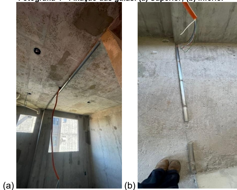
Fotografia 4 - Fixação das guias: (a) Superior; (b) Inferior
