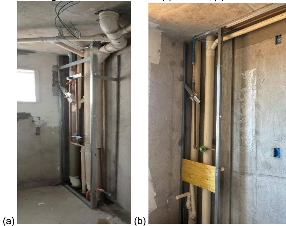
Fotografia 8 - Estrutura do shaft: (a) Banheiro; (b) Cozinha
