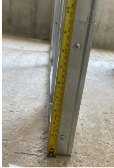
Fotografia 7 - Reforço realizados nos vãos de porta
