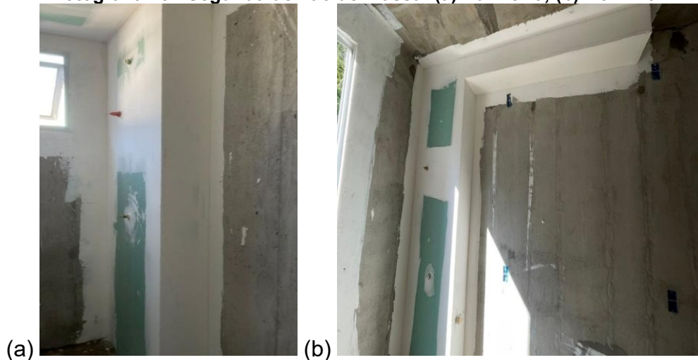
Fotografia 15 - Segunda demão de massa: (a) Banheiro; (b) Cozinha
