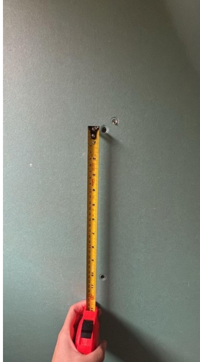
Fotografia 11 - Verificação do espaçamento entre parafusos de fixação das chapas
