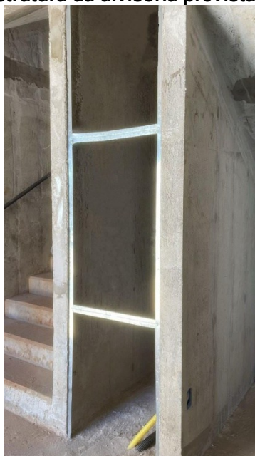
Fotografia 17 - Estrutura da divisória prevista no vão da escada
