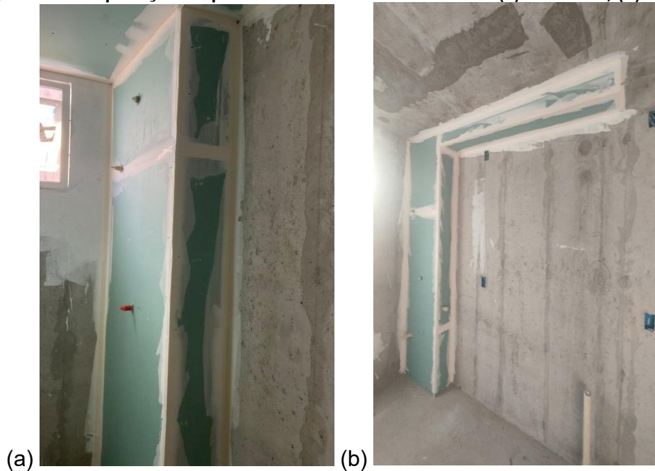
Fotografia 13 – Aplicação da primeira demão de massa e fita: (a) Banheiro; (b) Cozinha
