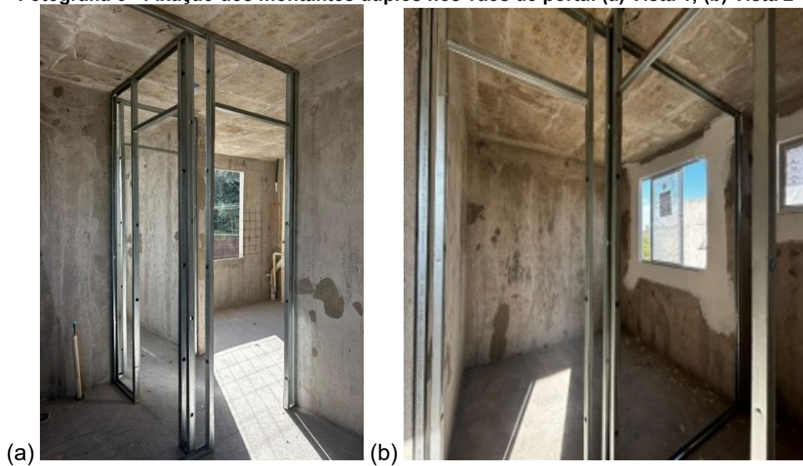
Fotografia 6 - Fixação dos montantes duplos nos vãos de porta: (a) Vista 1; (b) Vista 2
