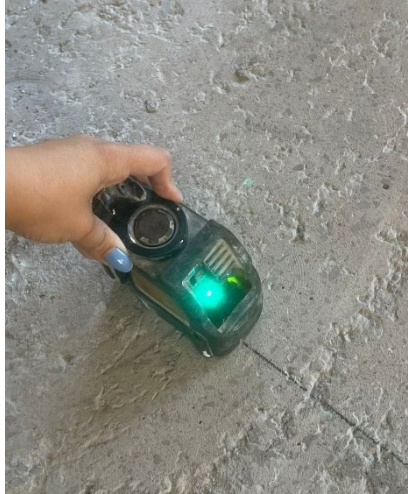
Fotografia 3 - Marcação com nível a laser
