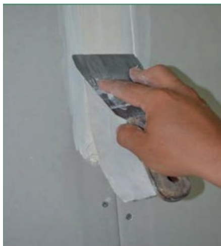
Figura 13 - Aplicação de fita microperfurada sobre a primeira demão de massa
