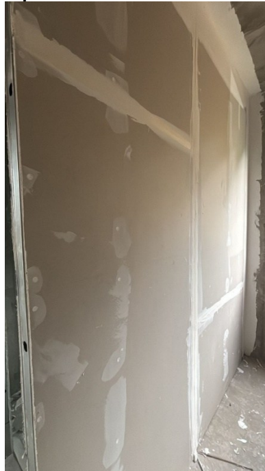
Fotografia 12 - Aplicação primeira demão de massa e fita na parede do quarto
