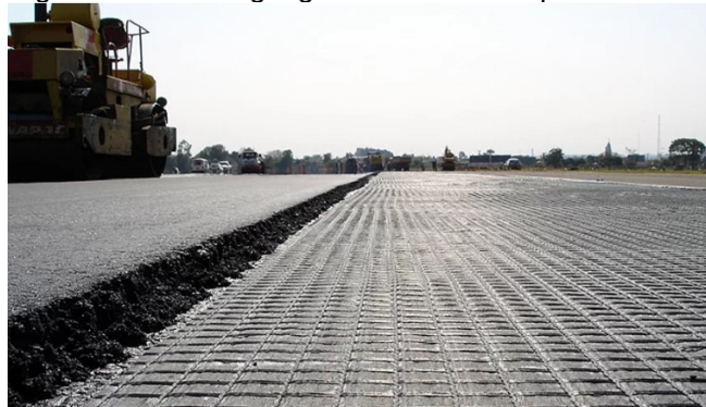
Figura 4 – Uso de geogrelha em estrada pavimentada.
