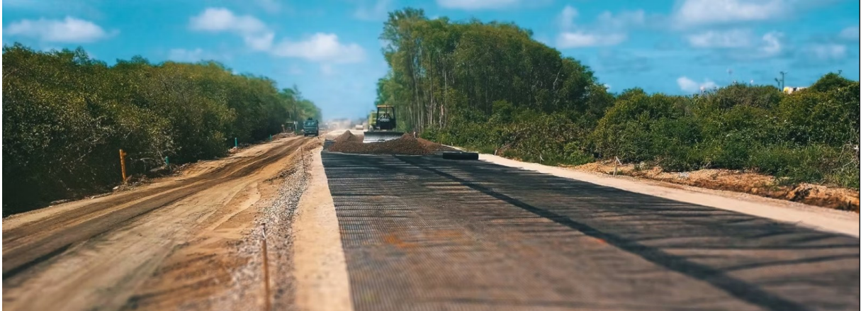
Figura 2 – Uso de geogrelhas em estradas não pavimentadas.
