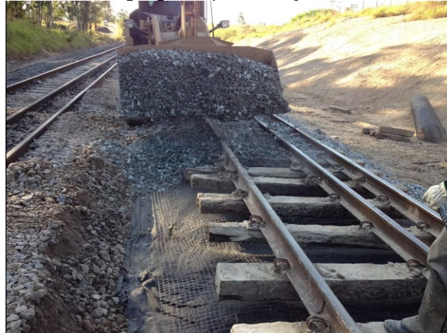
Figura 3 – Uso de geogrelha para reforço em lastro ferroviário.
