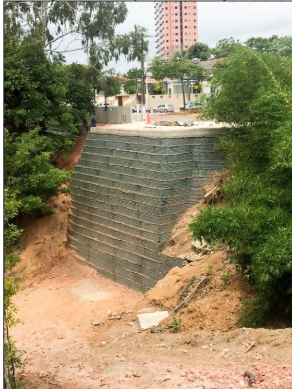
Figura 6 – Reforço em talude íngreme.
