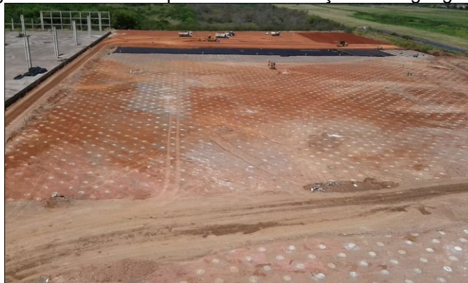
Figura 9 – Aterro estaqueado sendo reforçado com geogrelha.
