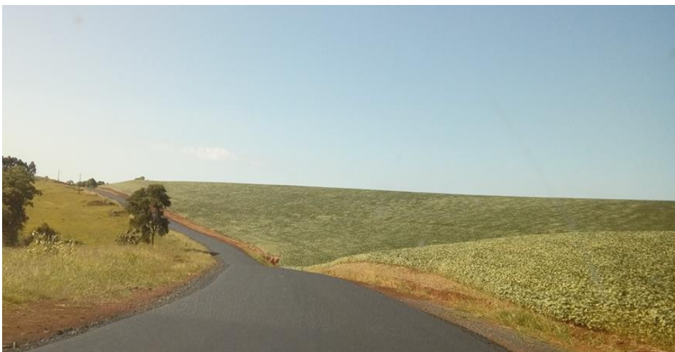
Figura 05: Estrada Municipal Belmiro Caldato revitalizada.
