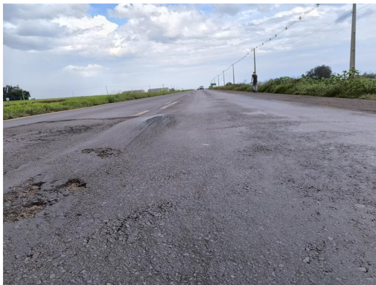
Figura 29 – Exemplo de afundamento de trilha de roda no trecho estudado
