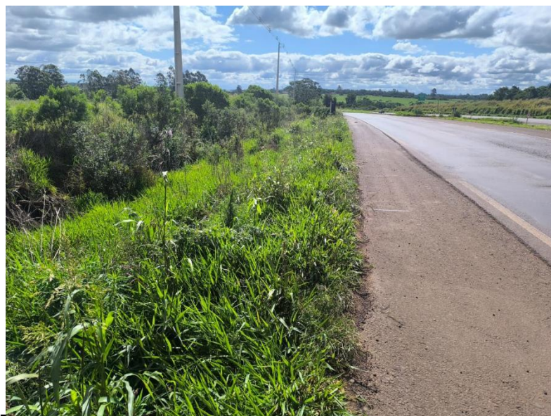
Figura 30 – Valeta lateral tomada por vegetação e sedimentos na BR- 163
