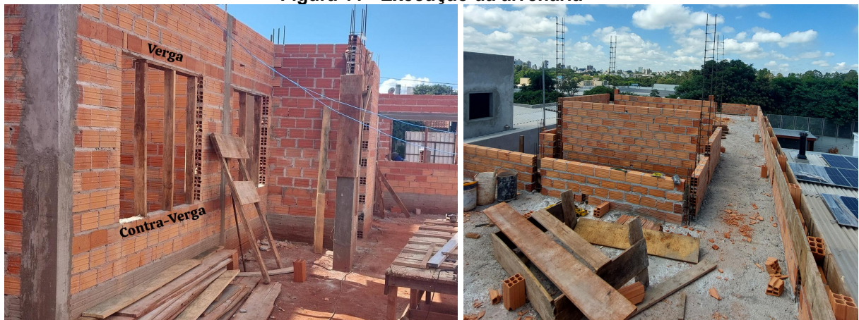
a) Alvenaria, vergas e contravergas (Obra 2) em blocos canaletas
