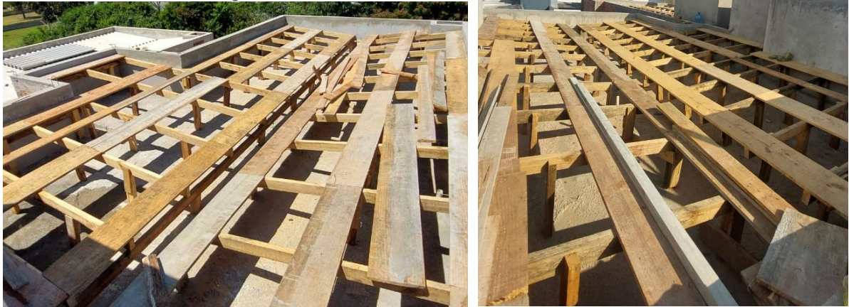
Figura 13 - Execução da estrutura da cobertura
