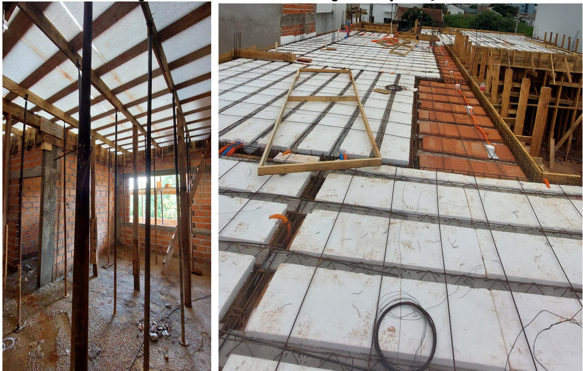
Figura 22 - Escoramento e montagem de laje treliçada
