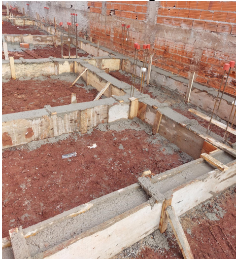
a) Vigas Baldrame - Obra 1
