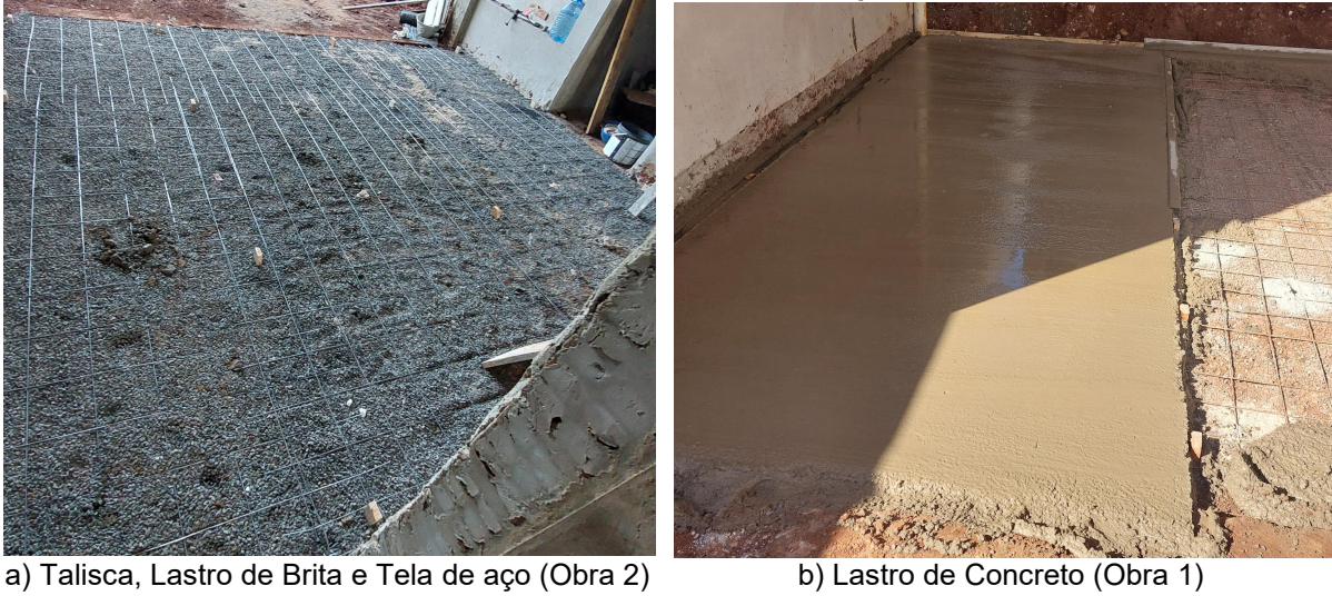
Figura 17 - Execução do contrapiso
