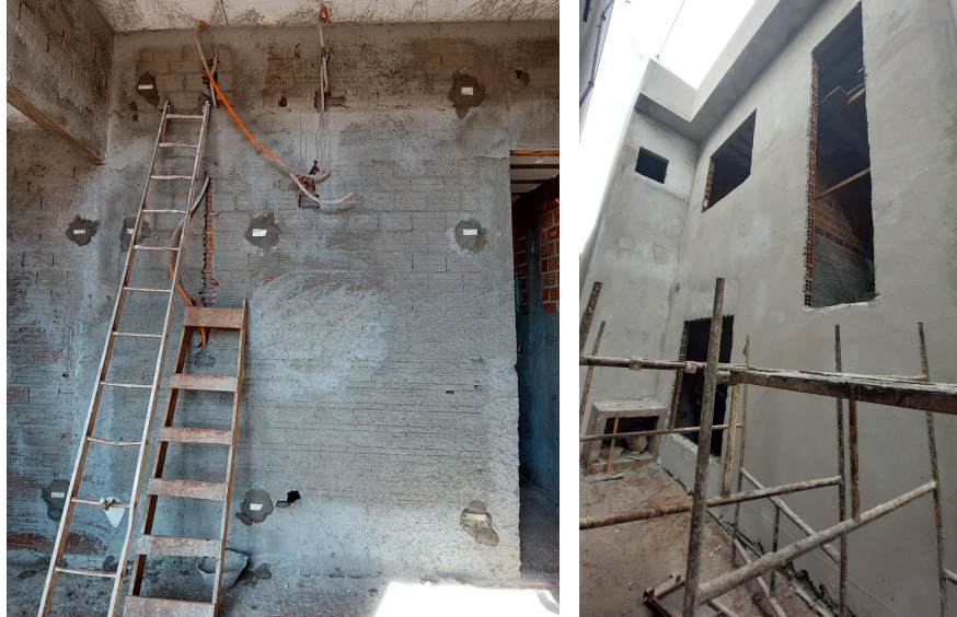
Figura 23 - Chapisco, taliscamento e emboço
