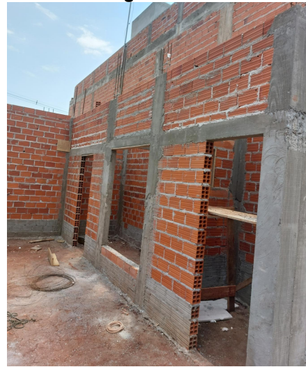
b) Vigas e Pilares - Obra 1
