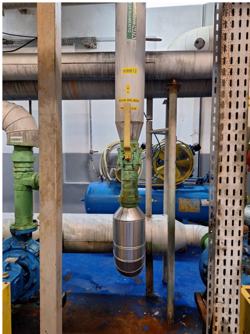
Figura 6 – Tubulação após retirada da bomba Fonte: Autoria Própria (2025)
