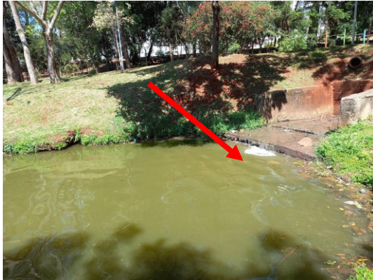
Figura 12 – Ligação clandestina ocorrendo no ponto amostral 3 – Margem Direita.
