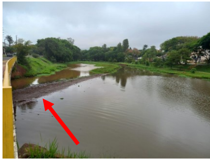
a) Presença de assoreamento na Margem Direita do Lago Igapó IV (P2)
