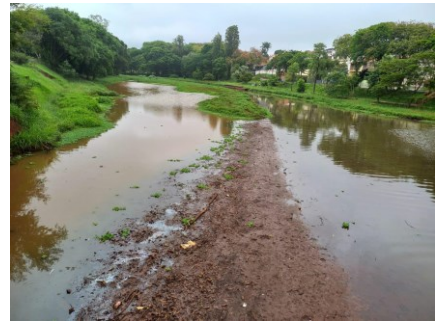
c) Assoreamento da Margem Direita do Lago Igapó IV (P3)
