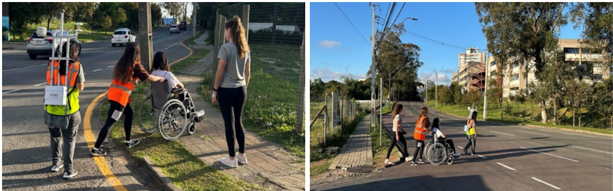
Figura 47 – Ausência de rampa em um dos lados no Cruzamento “Y” (à esquerda) e ausência completa de infraestrutura no Cruzamento “Z” (à direita)
