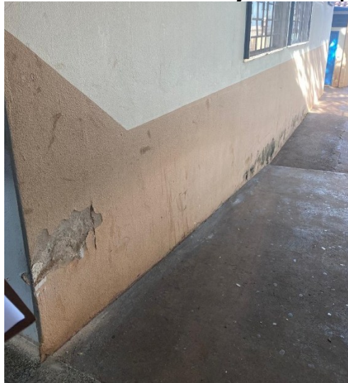
Fotografia 8 – Ausência de corrimão junto à rampa número 3
