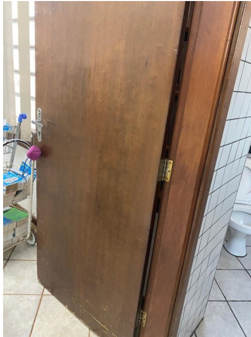
Fotografia 5 – Porta de acesso ao banheiro acessível (PcD)
