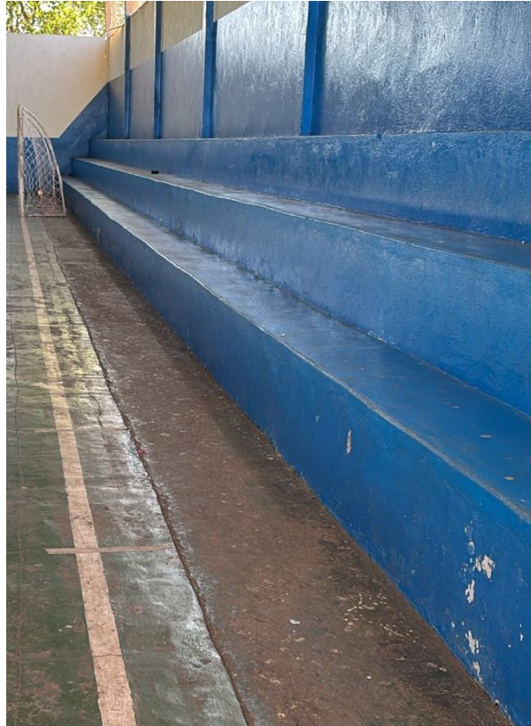
Fotografia 20 – Arquibancada da quadra poliesportiva
