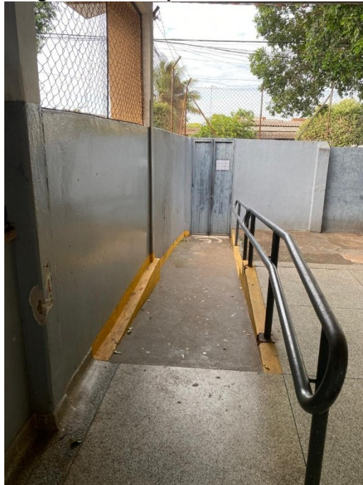
Fotografia 6 – Rampa de acesso número 2
