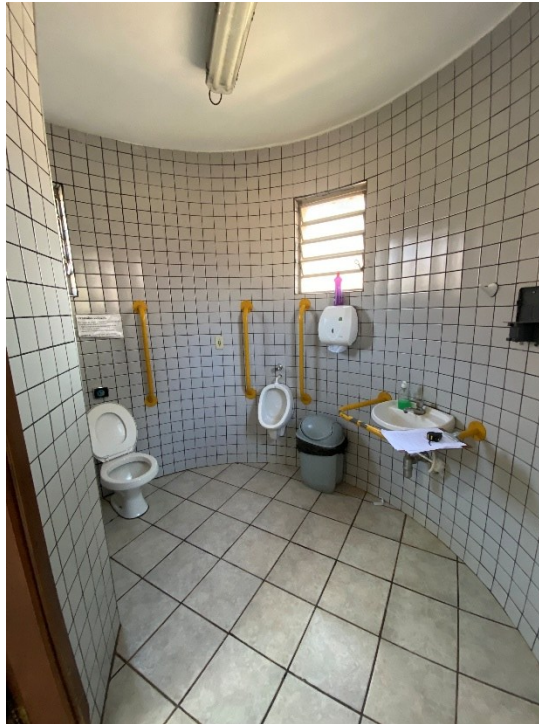
Fotografia 12 – Disposição de acessórios sanitários no banheiro acessível
