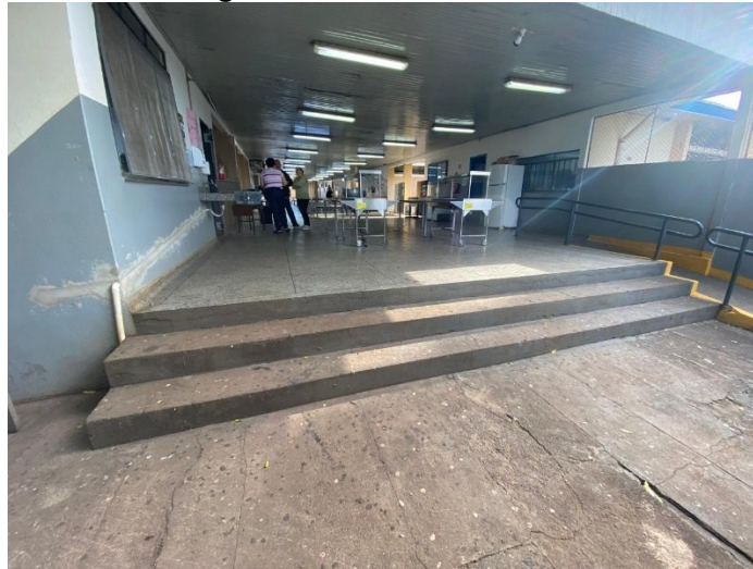
Fotografia 10 – Escada de acesso
