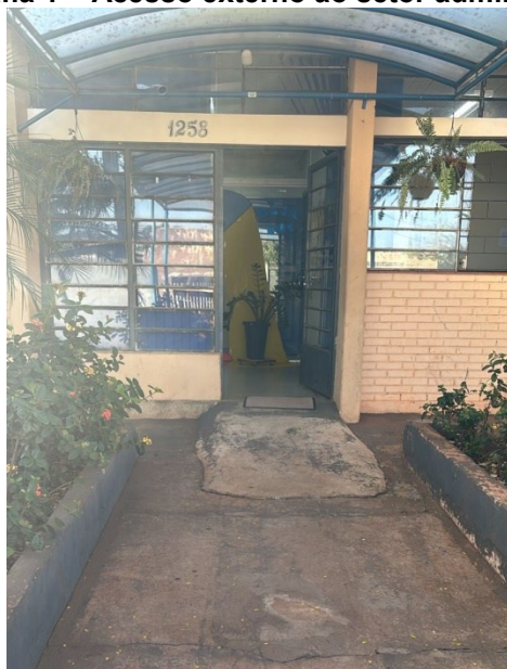
Fotografia 1 – Acesso externo ao setor administrativo
