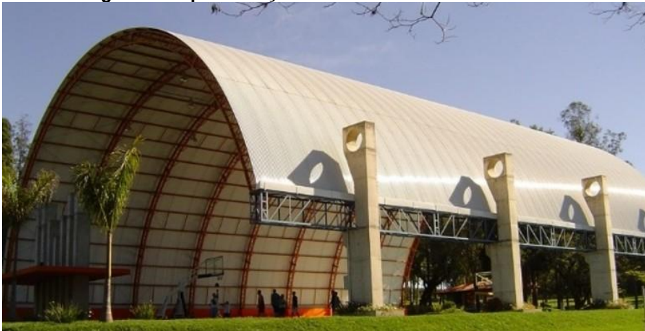
Figura 1: Representação de cobertura metálica em arco
