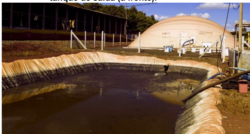
Figura 2.6 - Fotografia de biodigestor canadense (ao fundo) e tanque de saída (à frente).
