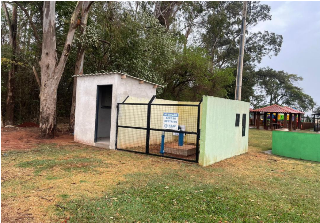
Figura 13 – Vista frontal das instalações do poço Bosque
