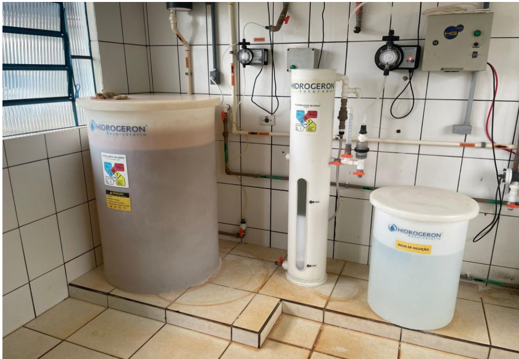
Figura 8 – Vista parcial do local de armazenamento de produtos químicos
