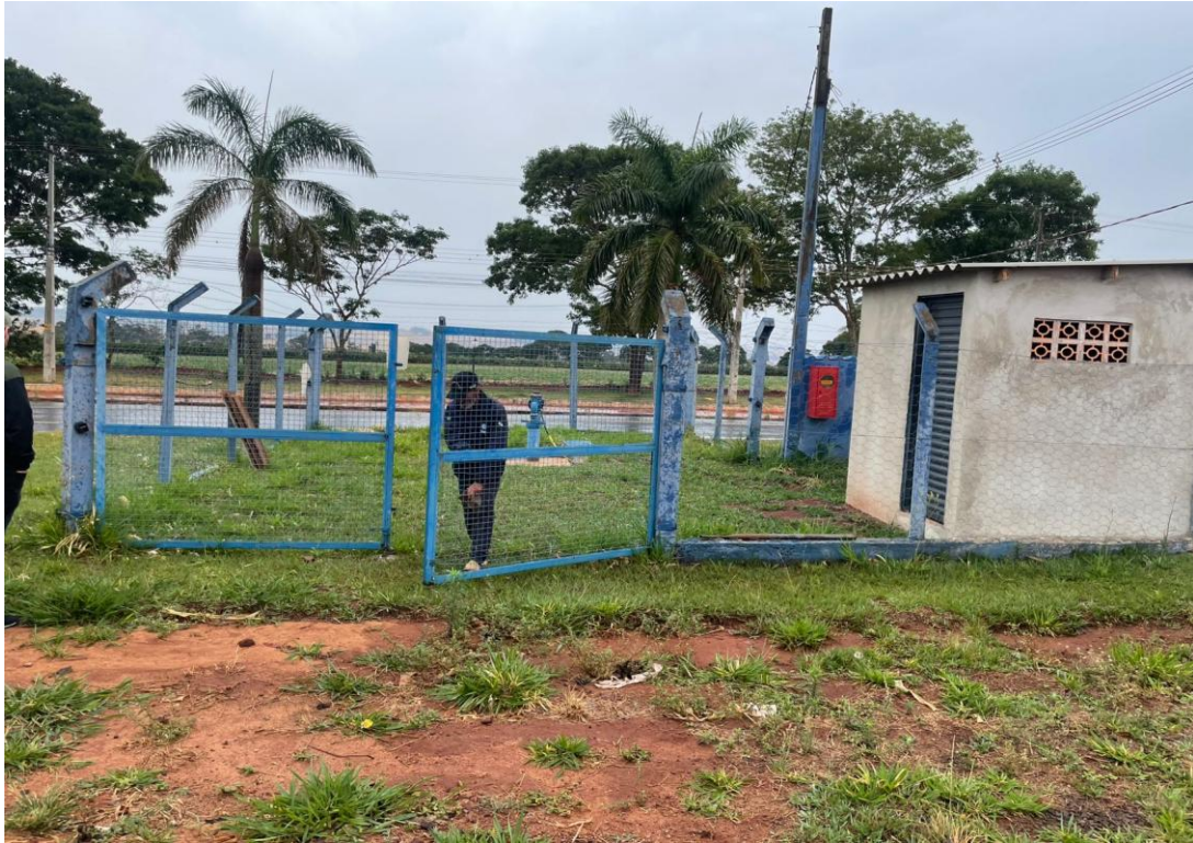
Figura 18 – Infraestruturas de cercamento e acesso do poço Parque Industrial
