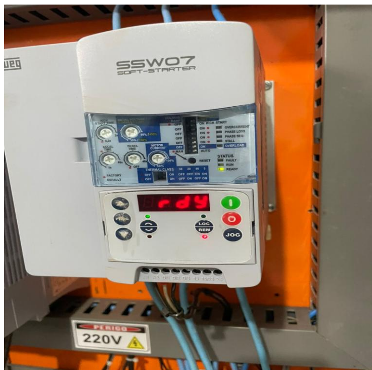
Figura 10 – Vista frontal do dispositivo eletrônico utilizado no poço Sede SAAE
