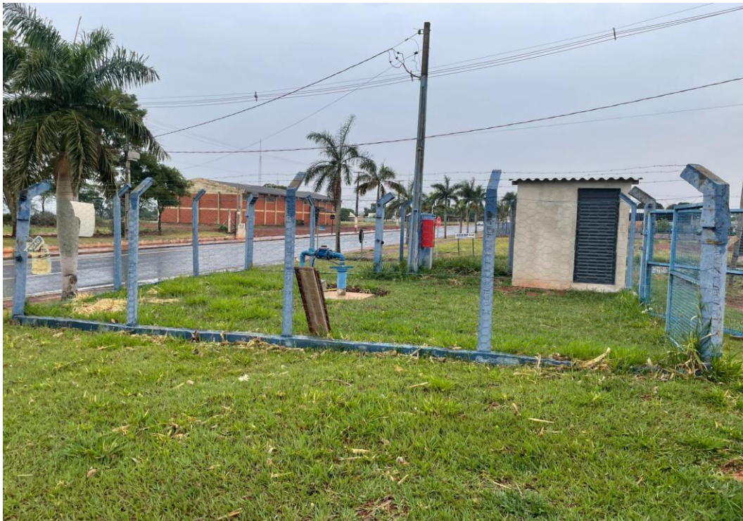
Figura 16 – Vista frontal das instalações do poço Parque Industrial
