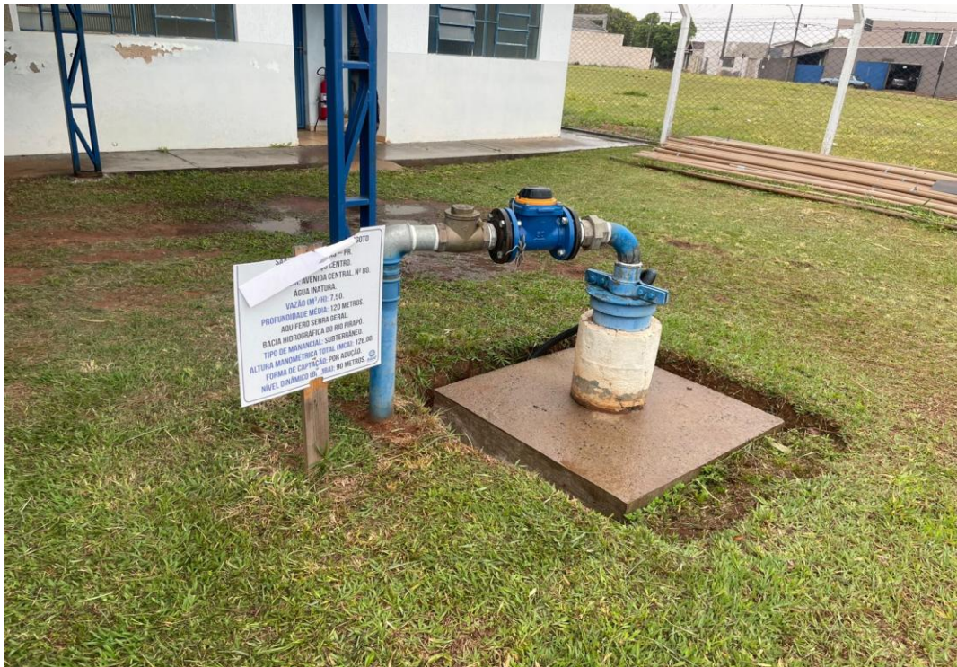
Figura 11 – Condições de entorno do sistema de bombeamento do Poço Sede SAAE
