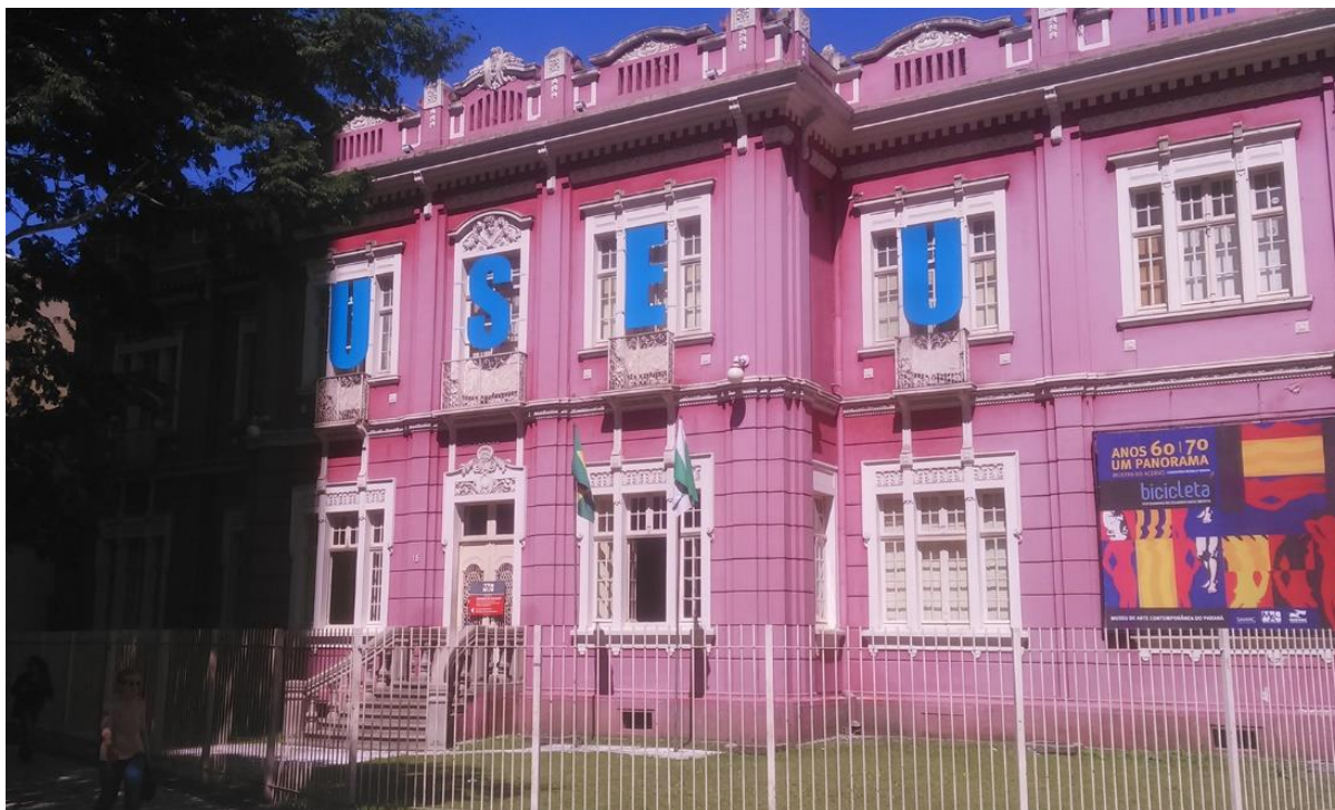
Figura 8 – A fachada do MAC-PR
