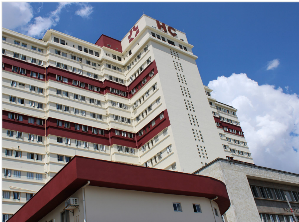
Foto 2 – Vista frontal do Prédio Central do CHC-UFPR
