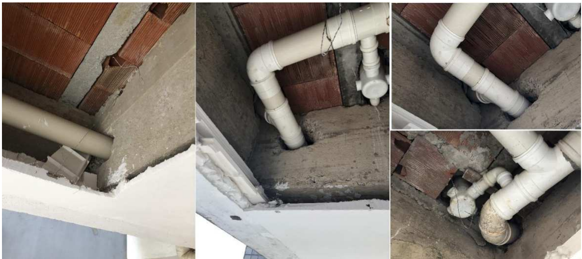
(a) Exemplo de passagem de rede hidráulica Fonte: Soares et al. (2021).
