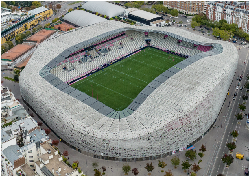
Figura 10: Painéis em UHPC no Stade Jean-Bouin, Paris, France Fonte: Müseler (2022).
