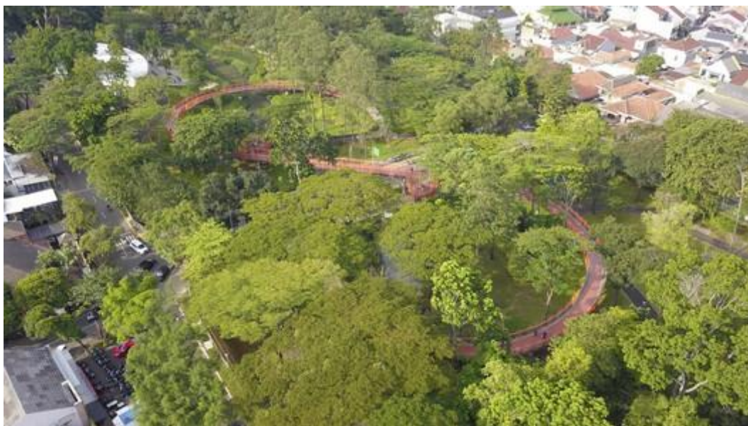
Figura 27 - Passarela principal que liga o Parque Norte e o Parque Sul
