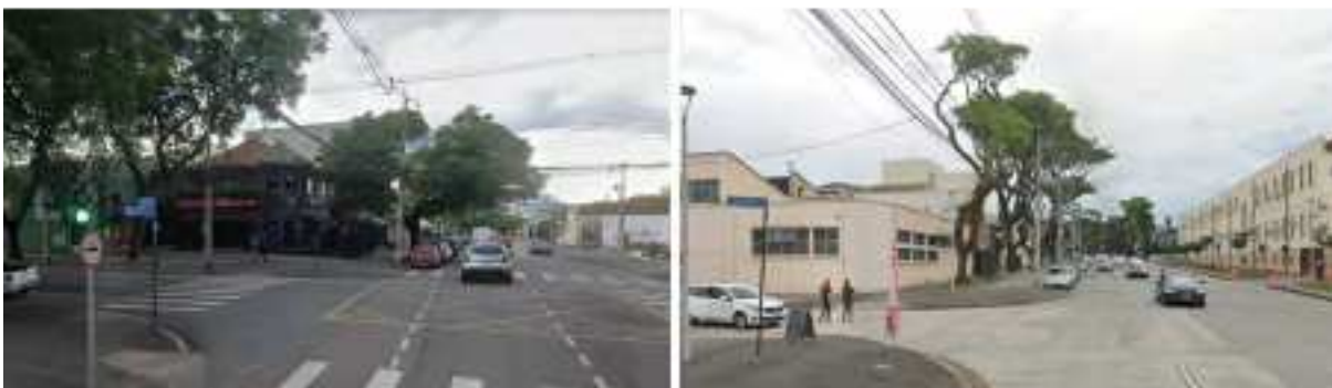
Figura 58 - EMF: Cruzamento entre Av. Pres. Getúlio Vargas e rua Des. Westphalen; e cruzamento entre Av. Pres. Getúlio Vargas e rua Santo Antônio, respectivamente
